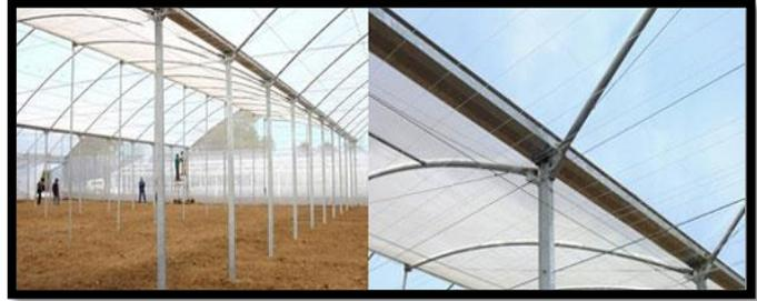
Figure 186 : la gouttière des serres, Source : <https://www.invernaderosima.com/>
