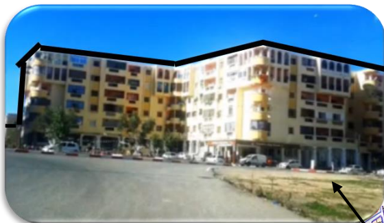
Figure2: 28 : Skyline Nord Habitat collectif R+5 (La cité Jawhara)
