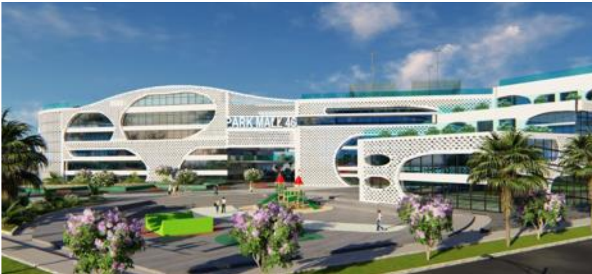
Figure4: 34 : vue latérale nord Est, source :l'auteur
