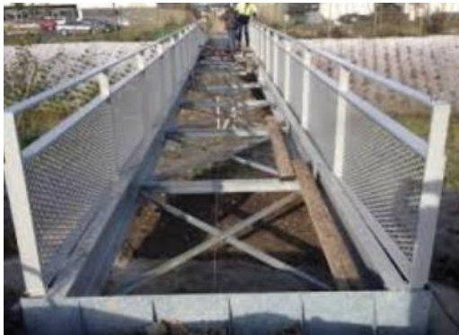
Figure4: 25 : mise en place d'une passerelle métallique source : internet
