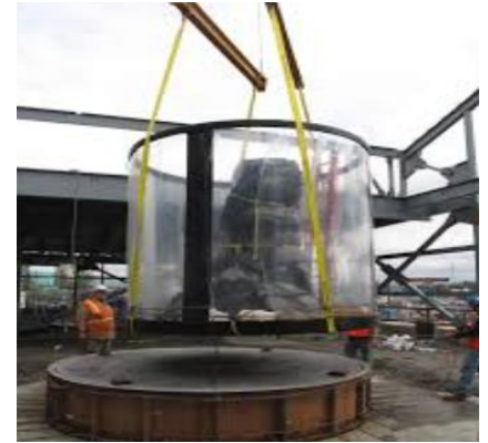
Figure4: 14 : construction d'un aquarium
