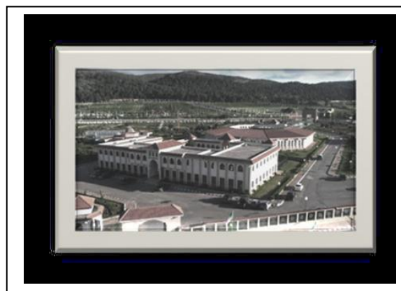
Figure87: façade urbaine de lalla
