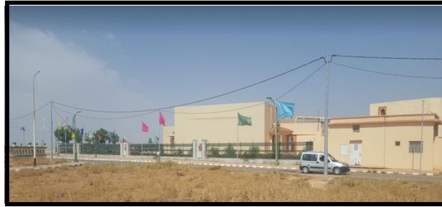
Figure 80 : vue du l'est
