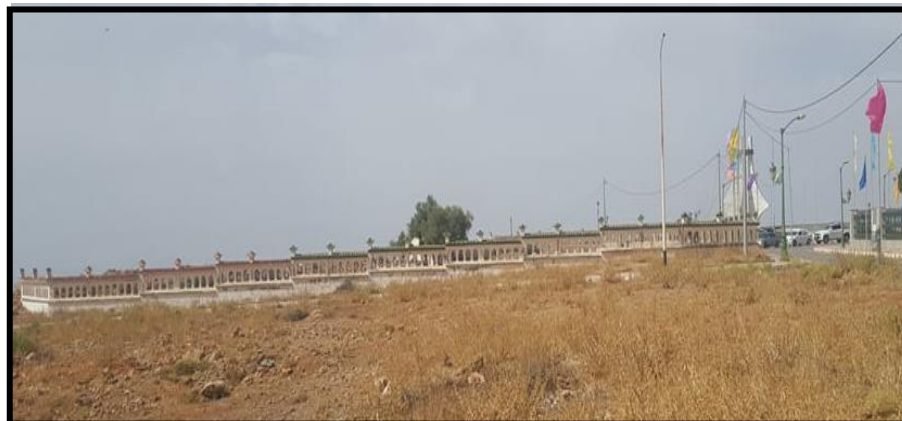
Figure 82 : Vue du nord -ouest
