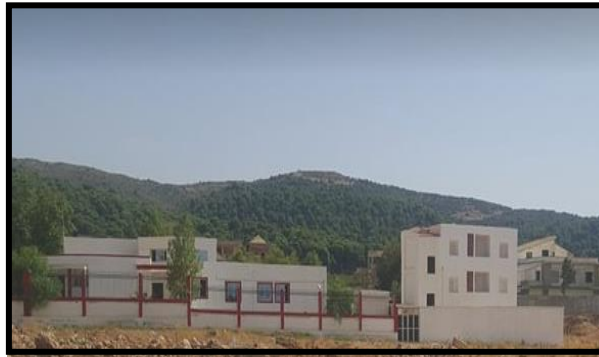
Figure 81 : vue du sud
