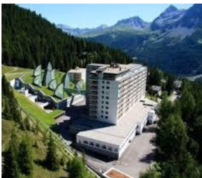
Figure 30 : vue sur le projet
