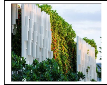
Figure 51 :vue sur la façade principale
