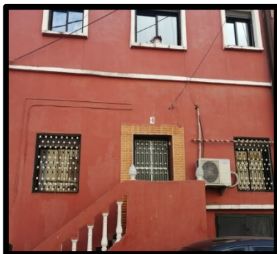
Figure 21: Habitation bon état Source : Auteur
