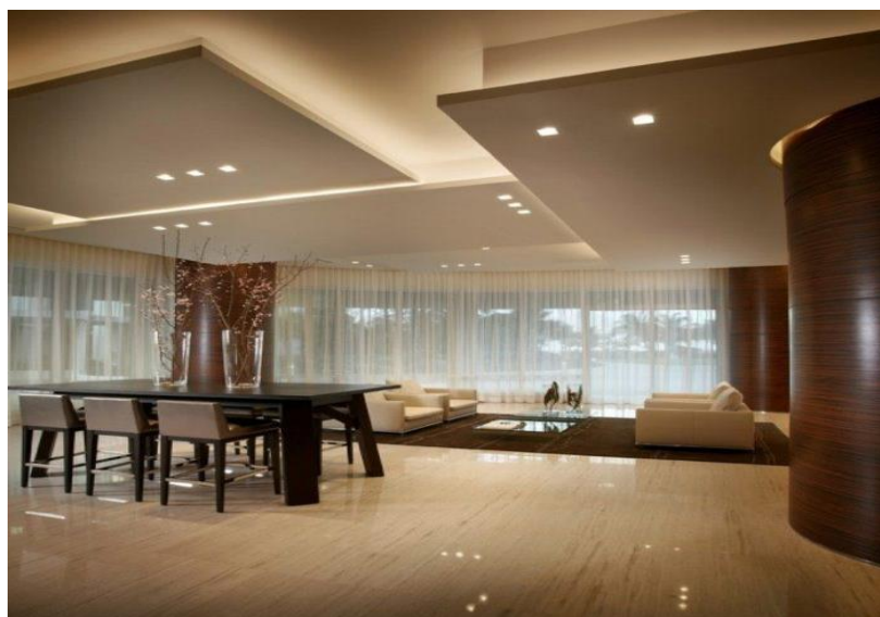
Figure 82 : exemple de faux plafond suspendu Source : https://www.pinterest.fr/pin/550213279464219361/
