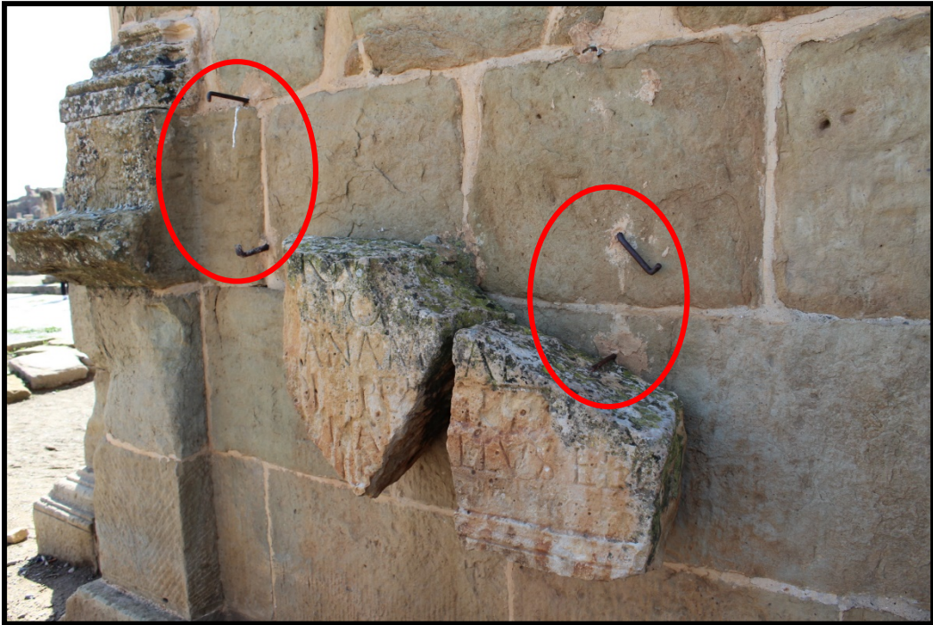
الصورة 30: ترميم باستعمال قضبان حديدية
