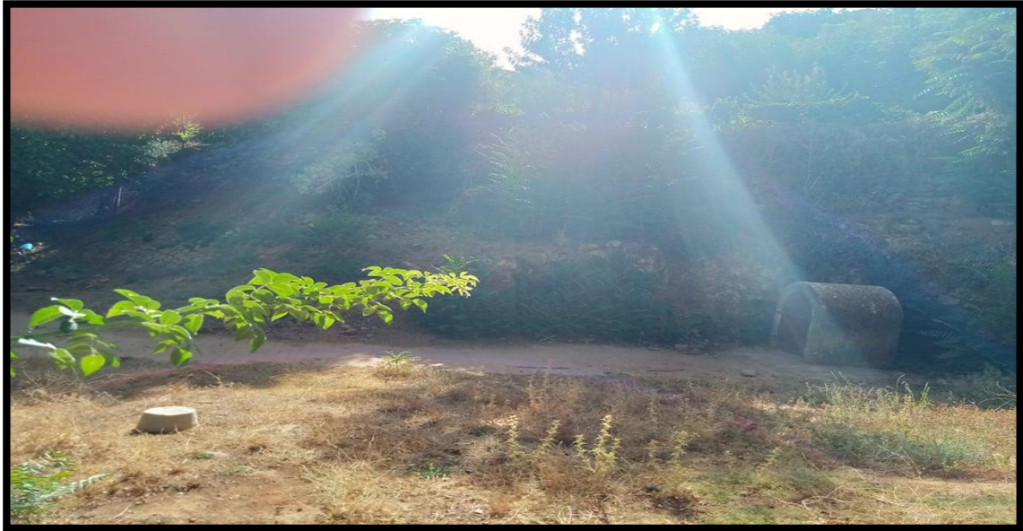
Figure III. 1: Chambre de captage de la source
