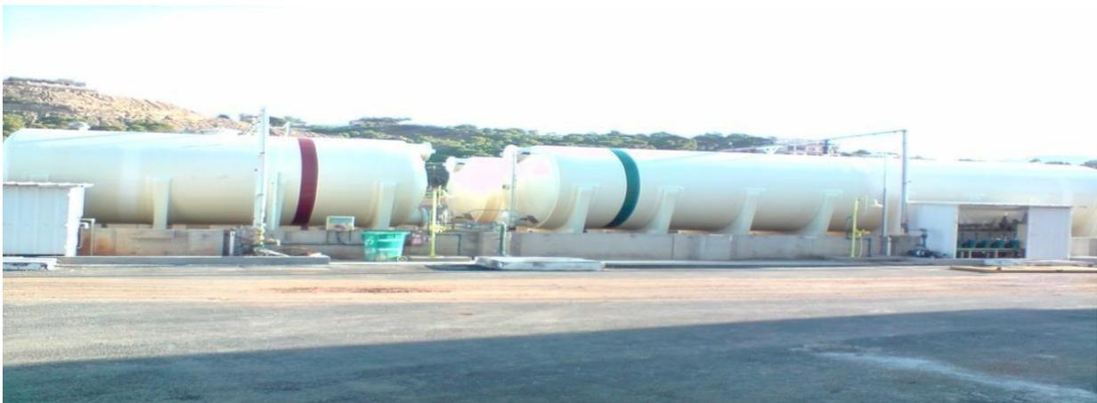
**Figure I-8:** Citernes de l'hypochlorite de sodium et chlorure ferrique
