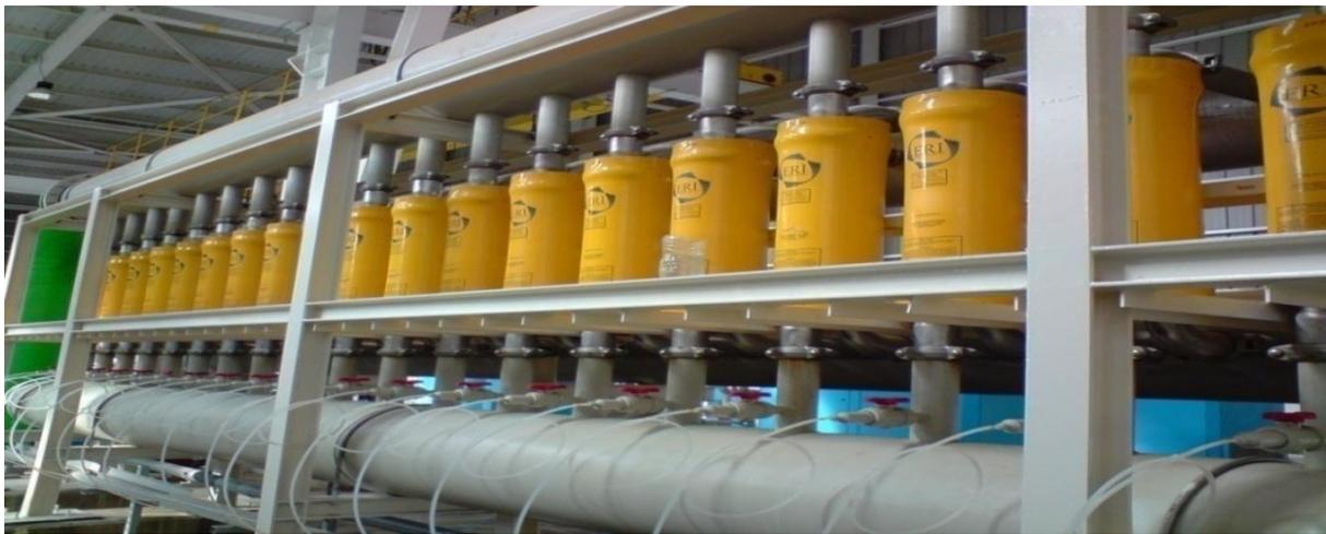
**Figure I-17:** Système d'échange de pression
