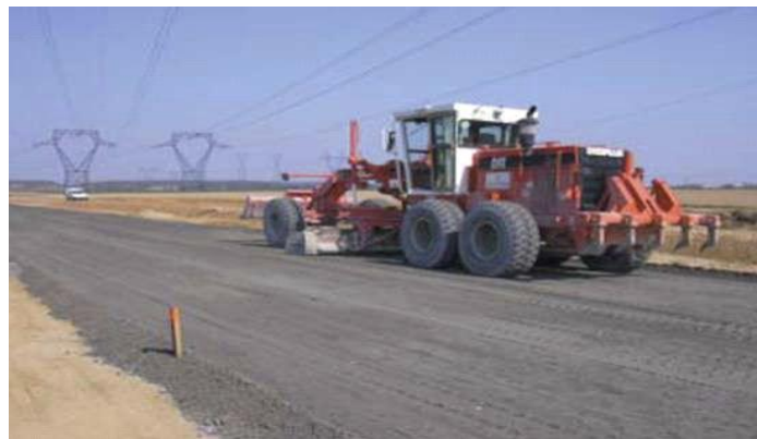
Figure 2.6 : Mise en œuvre d'une couche de fondation en sable traité.
