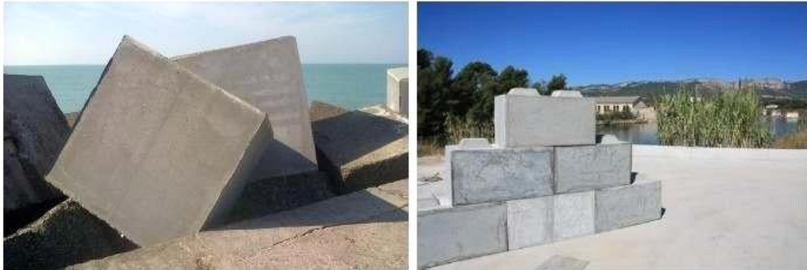
Figure 2.9 Blocs de bétons réalisés avec des sédiments non-immersibles traités (droite : Port de Dunkerque, gauche : Rade de Toulon)
