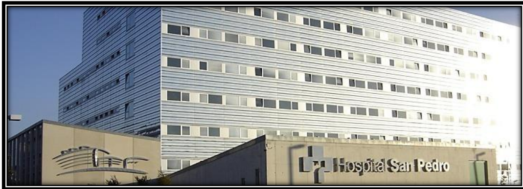
Figure 65: hôpital San Pedro, façade en acier inoxydable
