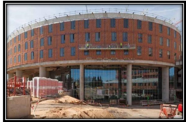
Figure 72: ossature en bois de l'hôpital (Nouvel hôpital d'Orléans en France)
