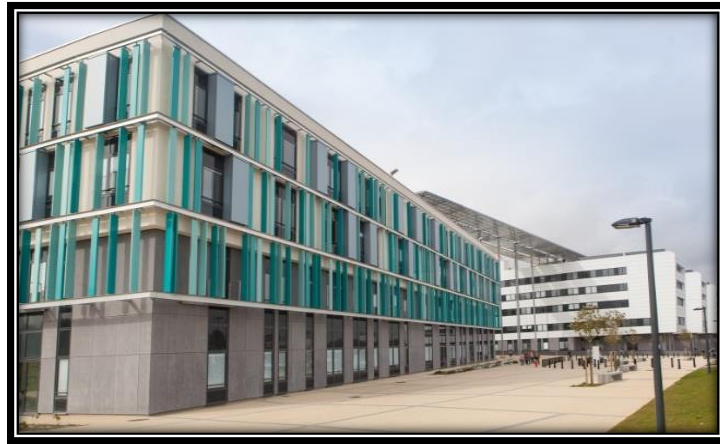
Figure 53: façade du centre hospitalier
