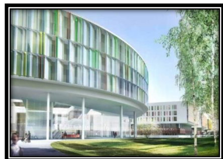
Figure 71: façade de l'hôpital
