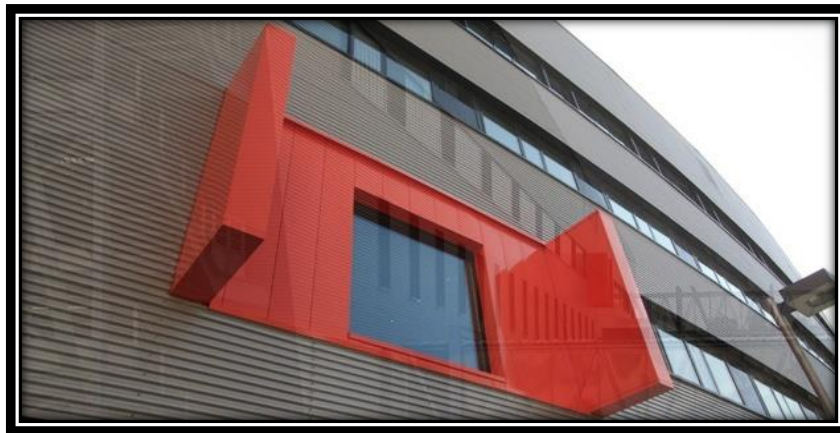
Figure 63: façade de l'hôpital
