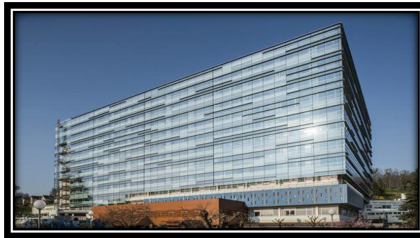
Figure 50: Façade de L'Hôpital
