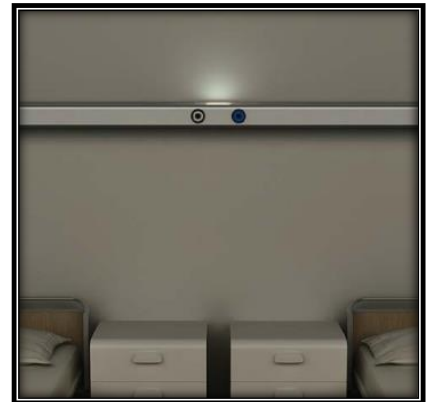
Figure 16: luminaire de veille dans une chambre
