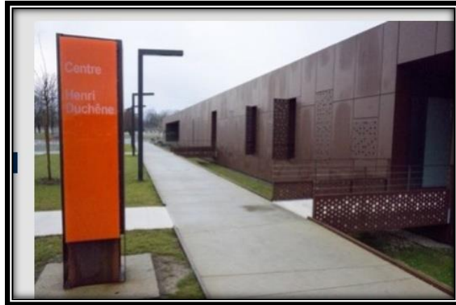
Figure 62: Façade réalisée en matériau Composite Aluminium teinte Oxyde Source : https://www.acodi.fr/r/26/2013-06-06-centre-hospitalier-des-pyrenees
