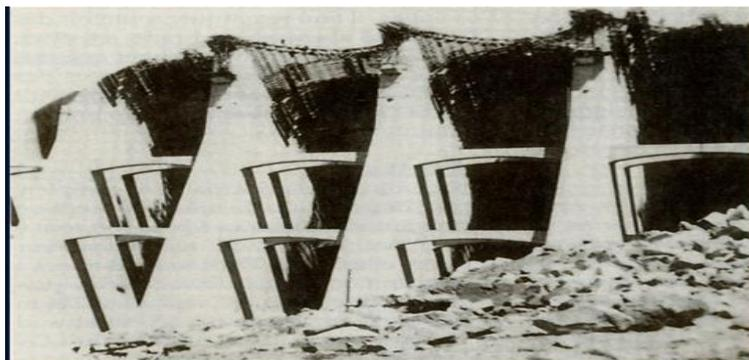
**Photo III.3 : Travaux de surélévation du barrage de Beni Bahdel [3]**
