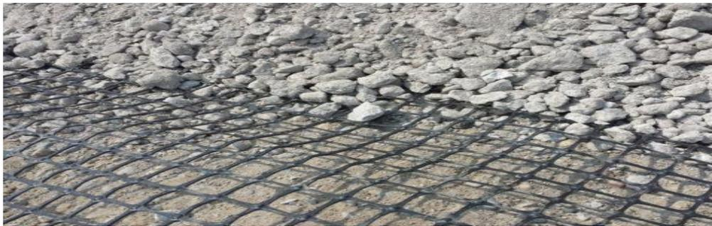
Figure 1-14 Géogrille biaxiale
