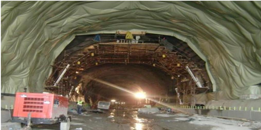
Figure 0-3 Utilisation de géotextile dans un tunnel à Oran 2018
