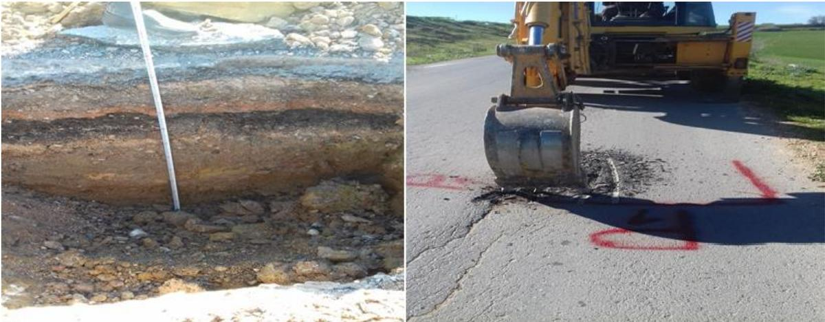
Figure 4-2 corps de chaussée en puits n°1
