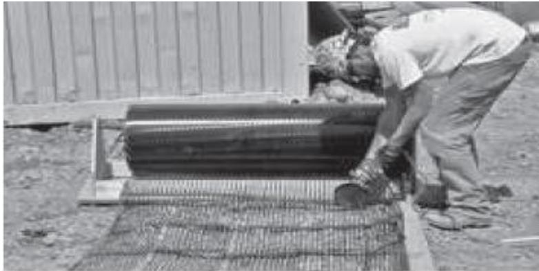
**Figure 4-28** : Champ coupant la géogrille UX
