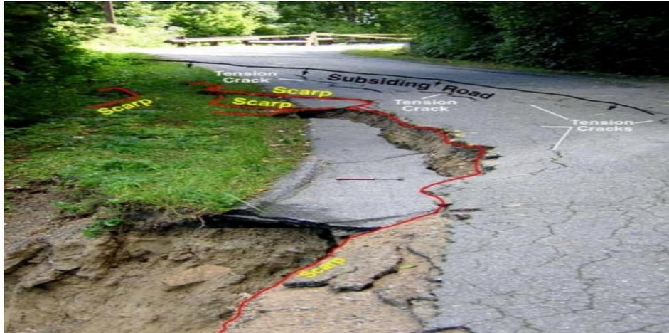
**Figure 0-7 :** avertissement des signes de remplissage instable (affaissement, fissures de tension, escarpements) Le coin inférieur gauche de la photo montre un escarpement majeur d'échec de remplissage de la route qui s'est mobilisé dans un flux de débris provenant des restes de fortes pluies de l'ouragan Francis en 2004 dans la subdivision Bear Rock Estates
