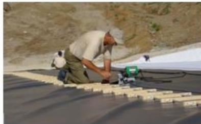
Soudure à l'air chaud par appareil à double soudure
