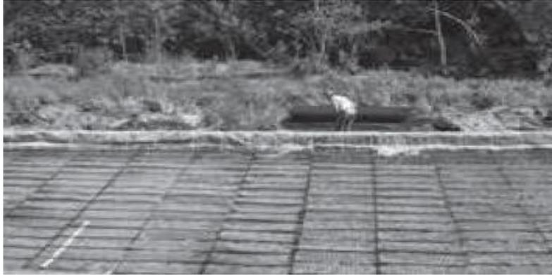
**Figure 4-30 :** Installation de la première couche d'une géogridde UX perpendiculairement à la face de la pente
