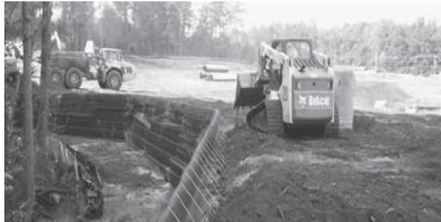
**Figure 4-31** : photo montre le processus de renforcement de talus par les géogrilles
