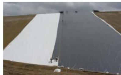
Déroulage et mise en place de la géomembrane
