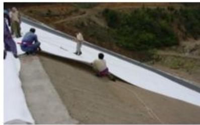
mise en place de géotextile pour l'étanchéité de barrage
