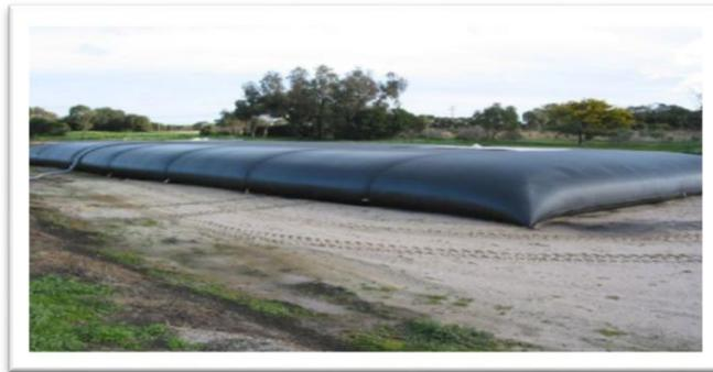
**Figure 2-7** : géotextile tube
