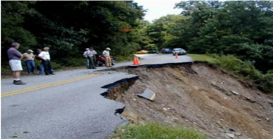
**Figure 0-6 :** promenade de la crête bleue (Milepost 348), rupture de la pente de remblai qui a déclenché l'écoulement de débris de Bear Drive Branch sur la forêt nationale de Pisgah, en Caroline du Nord (ouragan Frances, septembre 2004)
