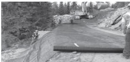
**Figure 4-33** : Les géogrilles Tensar BX utilisées pour le renforcement secondaire
