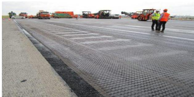
**Figure 2-22 :** Renforcement d'une chaussée avec une géogridde à haut module pour assurer son rôle d'anti-remontée de fissures
