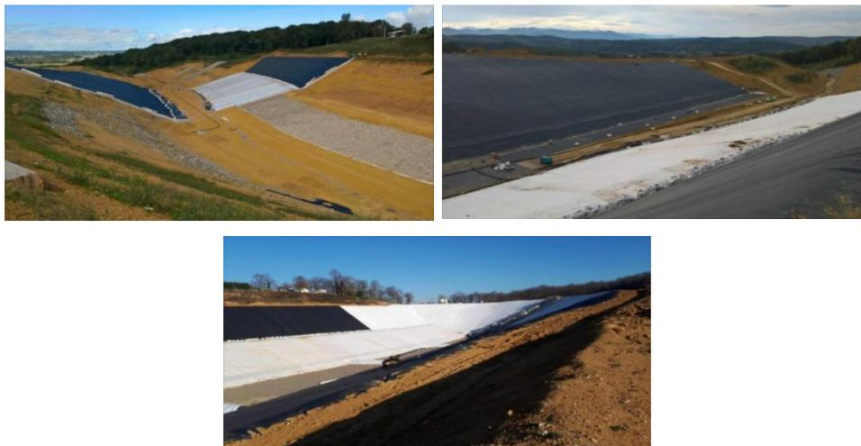
**Figure 2-24 :** Ouvrage montre l'étanchéité de casier pour l'installation de stockage de déchets non dangereux
