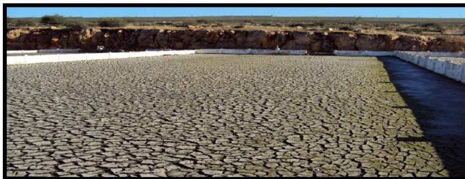
Figure IV.15 : Photo d'un lit de séchage.
