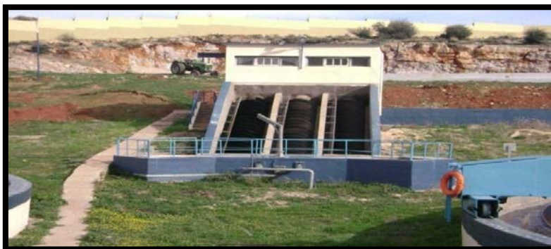
Figure IV.13 : Vis de recirculation (vis d'Archimède).
