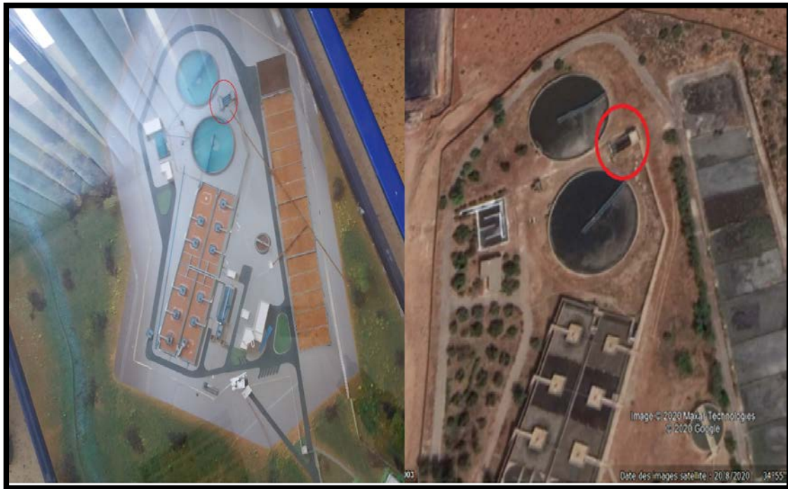
Figure IV.20 : Position de la vis de recirculation sur la STEP .
