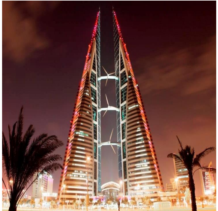
Figure 21 : Les deux tours de W Trade centre de Bahreïn
