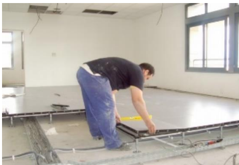
Figure : Installation d'un plancher technique
