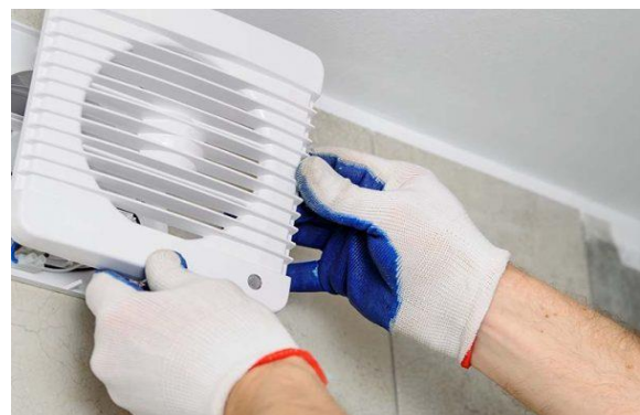
Figure 10 : Ventilation mécanique contrôlée
