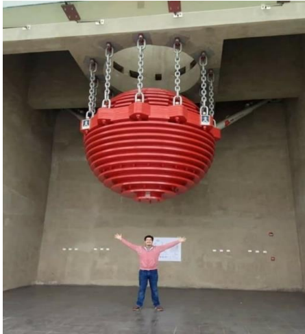
Figure : Amortisseur de stabilisation sphérique
