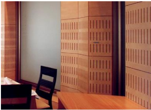
Figure : Plaque de bois perforé (résonateur).
