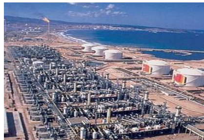
Figure 112 : Port de Bethioua : port pétrolier
