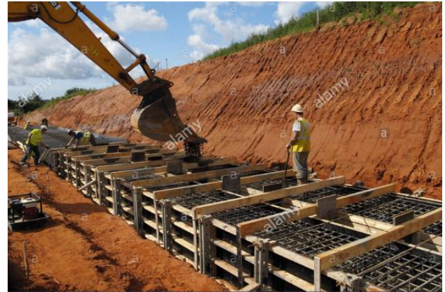
Figure 192 : Mise en œuvre sur chantier
