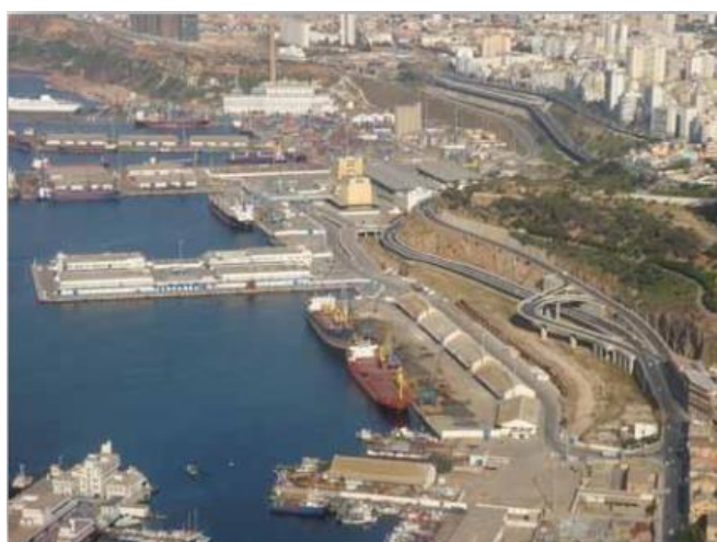
Figure 134 : Zone industrielle de Béthioua
