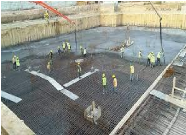
Figure 187 : Mise en œuvre sur chantier
