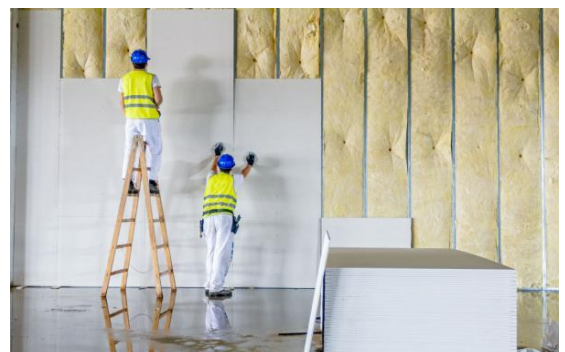
Figure : Processus d'installation (mise en œuvre)
