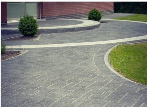
Figure : Pavage extérieurs
