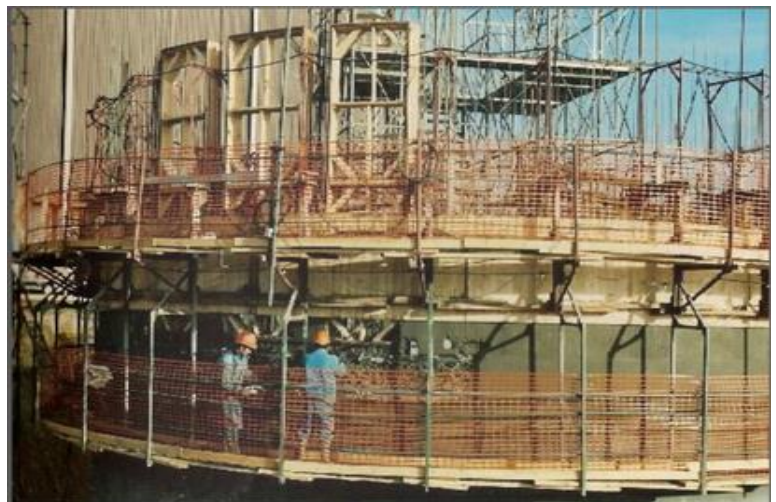
Figure 190 : mise en œuvre sur chantier d'un coffrage glissant 76
