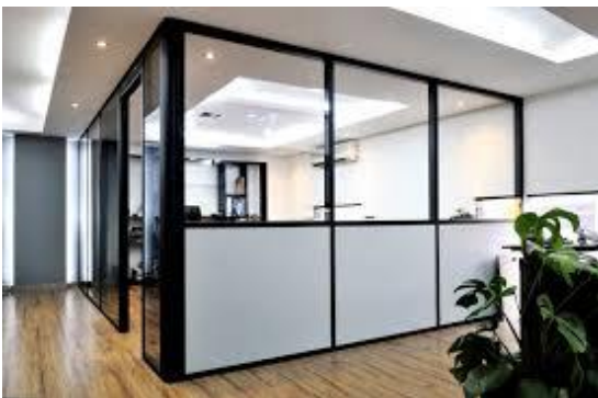
Figure : cloison semi vitrée
