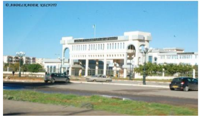
Figure 119 : Hôpital 1 er novembre
