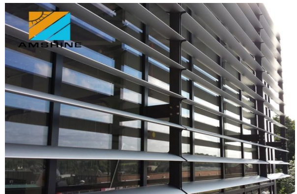
Figure 80 : Des Lames fixes dans une façade ouest
