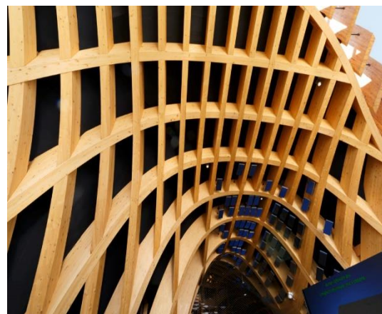
Figure 74 : Construction avec le bois lamellé-croisé
