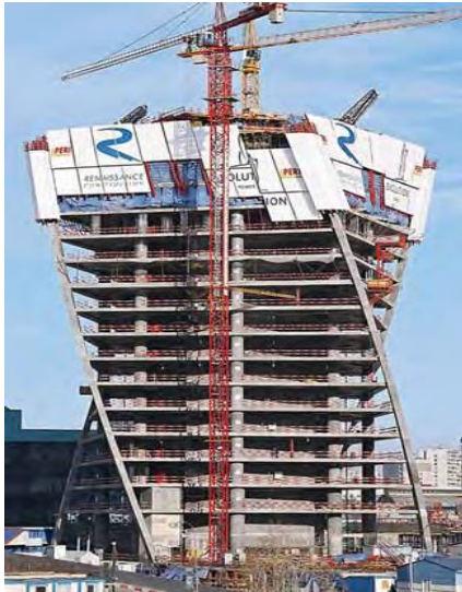
Figure 50 : Panneau de protection RCS enfermant les trois premiers étages en construction.
