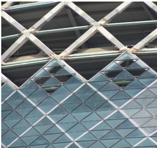
Figure 44 : Installation de panneaux de verre
