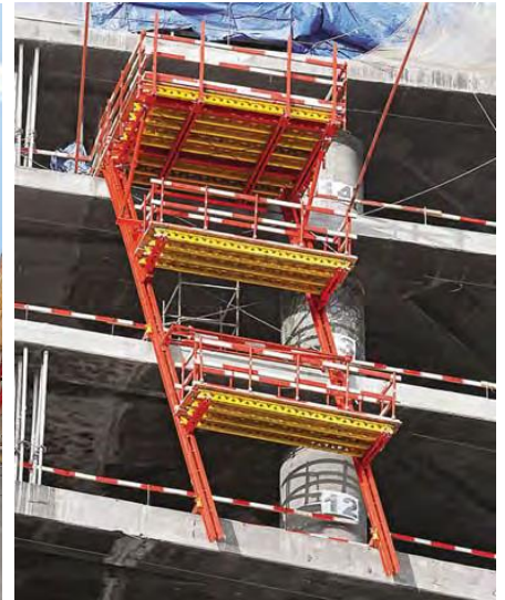
Figure 52 : Plateforme d'atterrissage RCS
