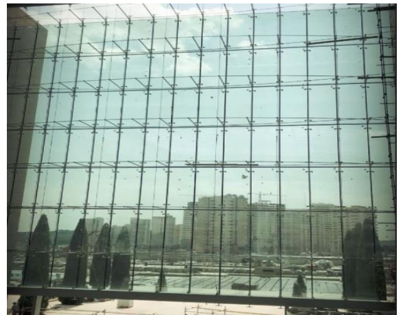
Figure 97 : Utilisation de ferme de câble
