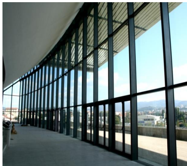
Figure 72 : L'utilisation de mur rideau
