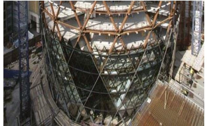
Figure 210 : Double peau en métallique (chantier)
