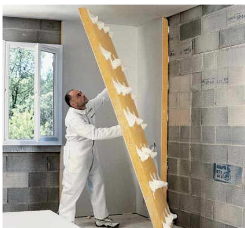
Figure : Installation de cloison en double parement
