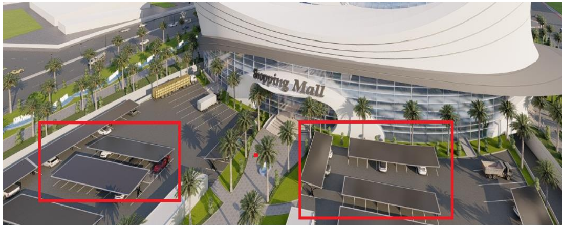
Figure : L'utilisation des panneaux dans le parking extérieur
