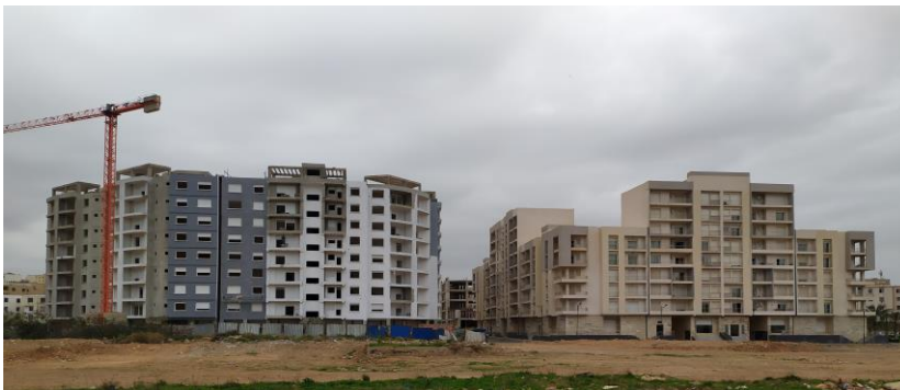
Figure 166 : Habitat collectif en cour de réalisation
