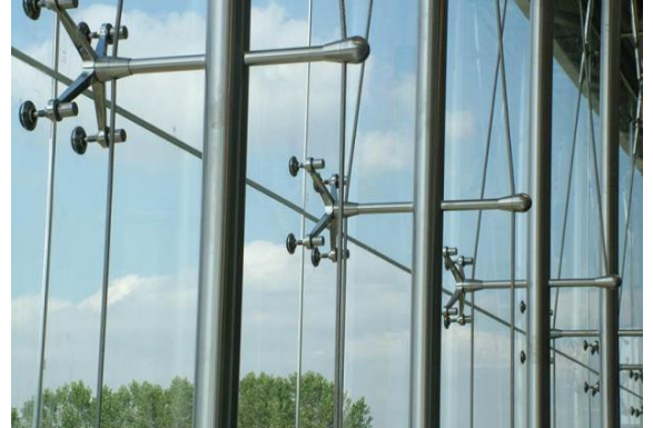
Figure 96 : Pilier ronds avec système arachnide
