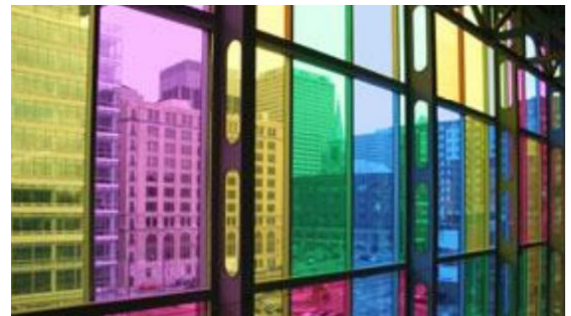
Figure 64 : un type de verre teinté antisolaire
