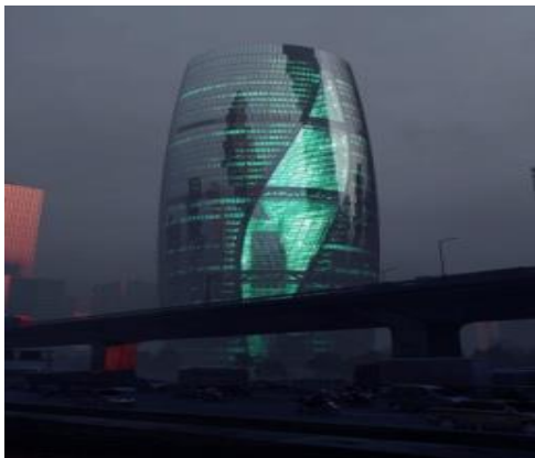
Figure 38 : Leeza Soho vu d'enveloppe
