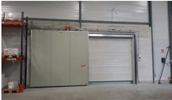
Figure : Grand porte coupe-feu (dépôt).
