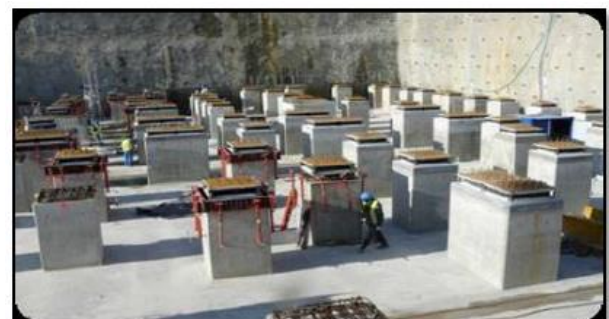
Figure 186 : Système plots antisismique sur le radier
