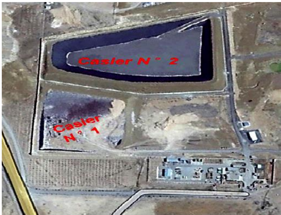
Figure III-18: le compactage dans les casiers
