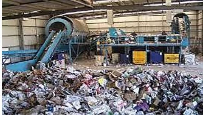
Figure III-19: l'opération de tri au niveau d'unité de tri M'sila
