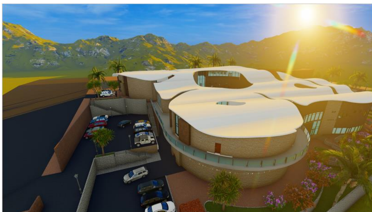
Vue du projet depuis la rue
