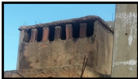
Figure 43. Cheminée de Canoune
