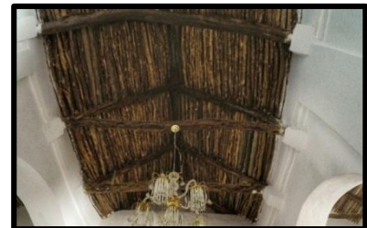
Figure 37. La toiture en touilla
