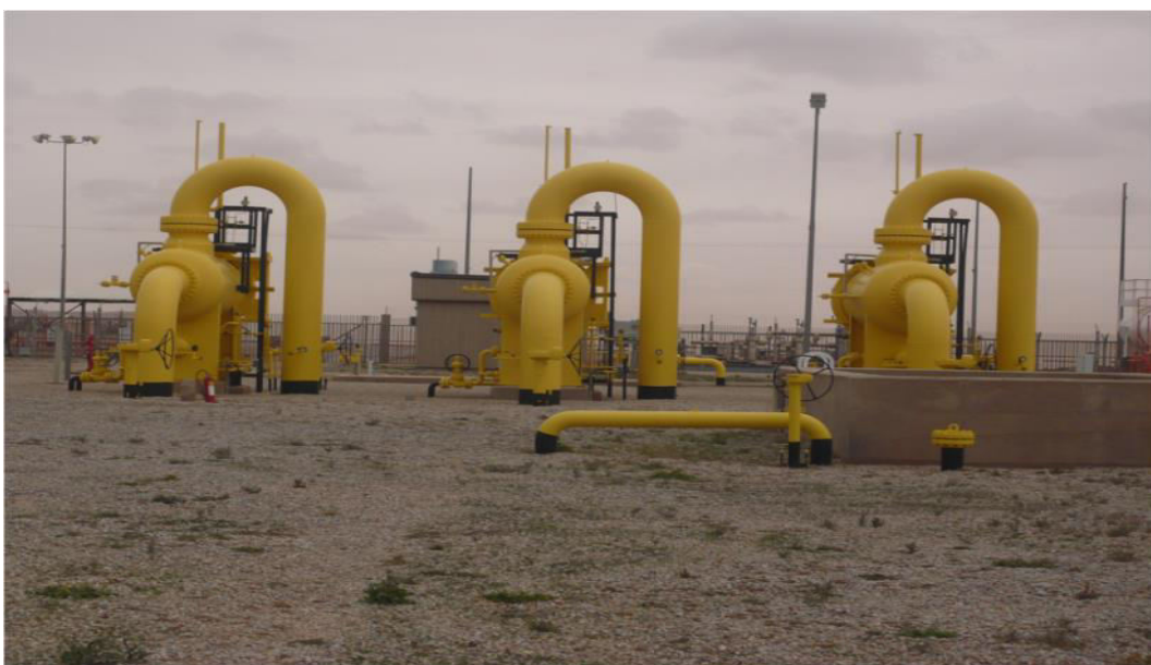
Figure I.6 : Filtres séparateurs [1].
