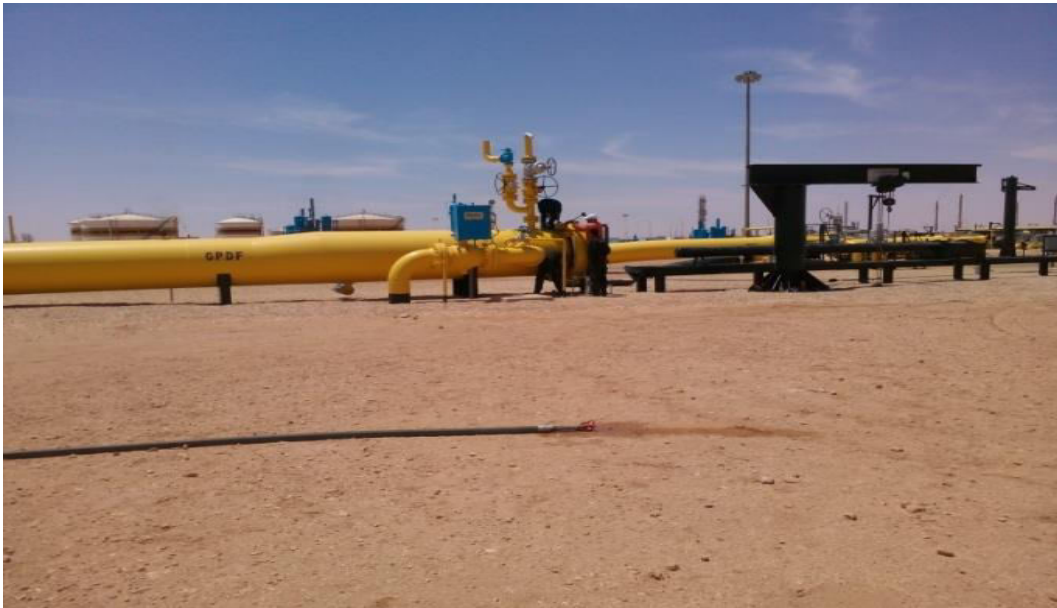
Figure I.5 : Gare arrivée du piston- racleur [1].
