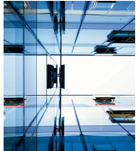
Figure 144 Exemple d'un mur-rideau
