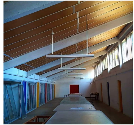
Figure 54 L'atelier de l'EPAU Alger
