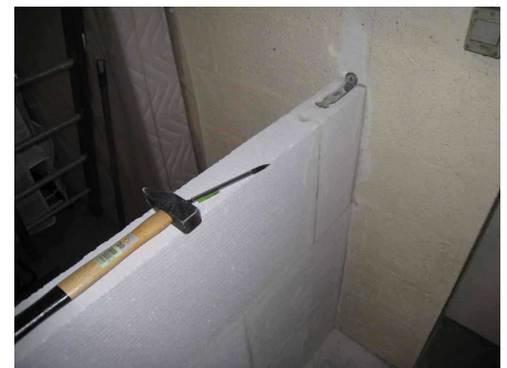
Figure 143 Exemple d'une cloison en siporex
