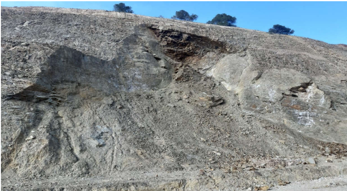
Figure 4.9 : Photographies de la section PK1+200-PK1+700
