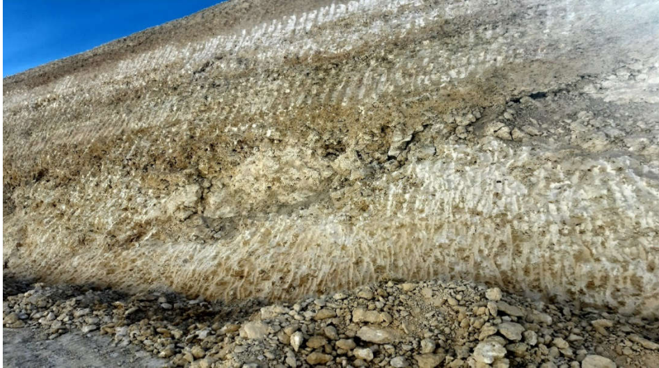
Figure 4.10 : Photographies de la section PK 1+700-PK1+900
