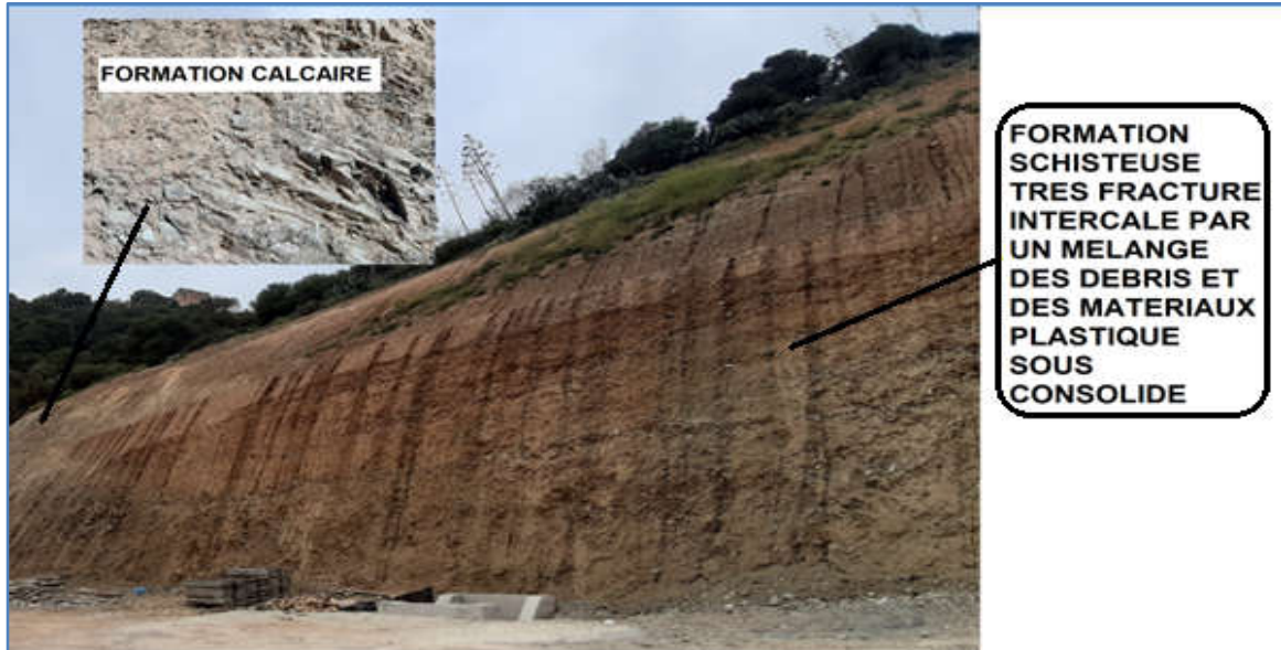
Figure 2.6 :Formation géologique de sectionPK0+330-PK0+700 (S3)
