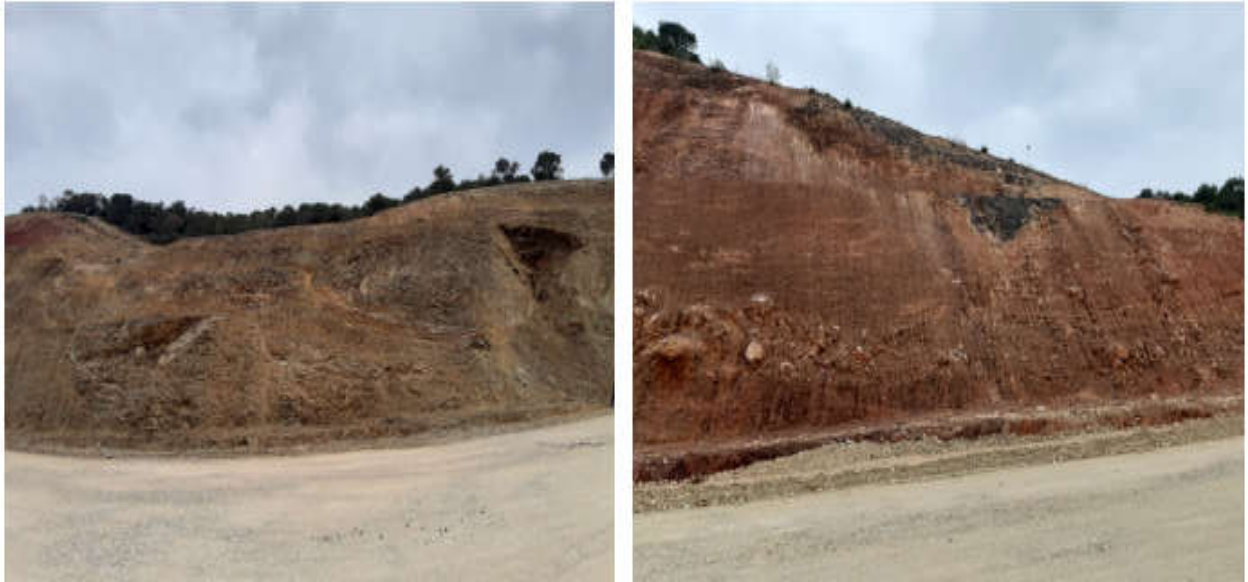
Figure 4.8 : Photographies de la section PK1+000-PK1+200
