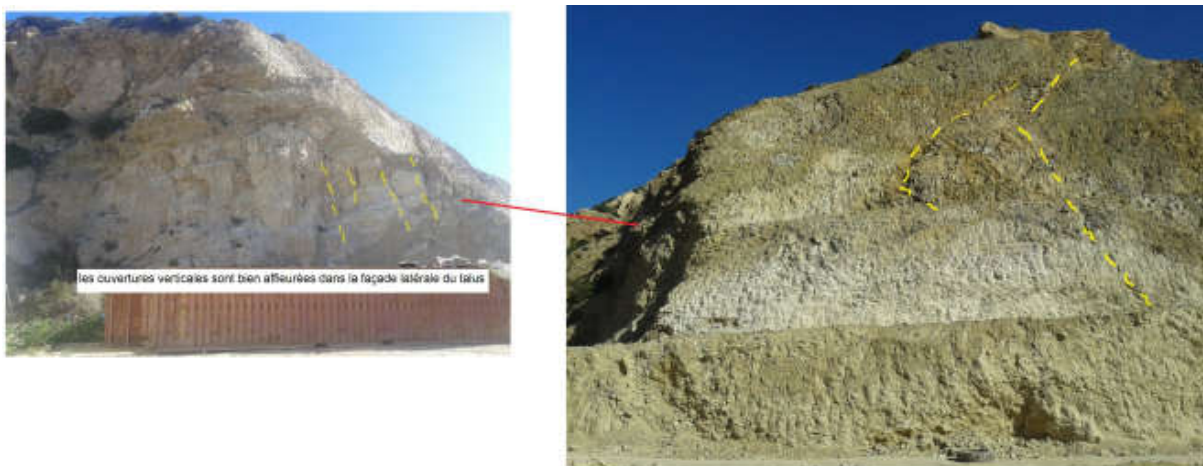
Figure 4.1 : photographie de la section PK0+000-PK0+80(côté gauche) IV.2.1.2 PK0+000-PK0+80 (Côté droit)
