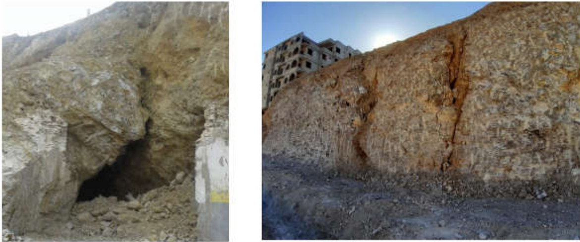
Figure 4.2 : photographies de la section PK0+000-PK0+80 (côté droit)
