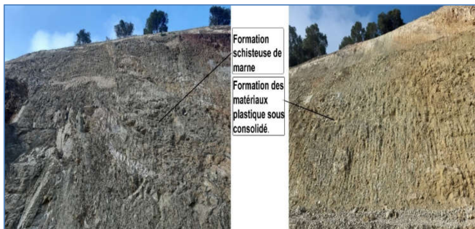
Figure 2.9 :Formation géologique de section PK1+200-PK1+700 (S6)
