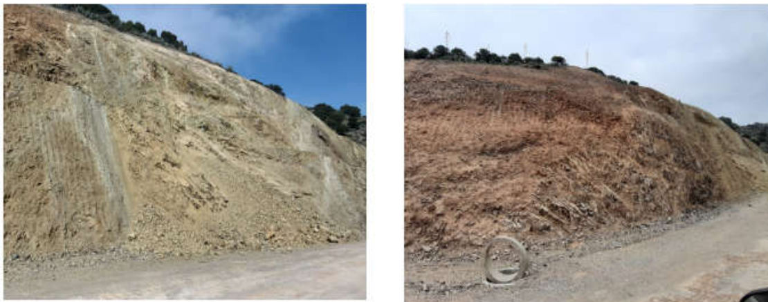
Figure 4.5 : Photographies de la section PK0+180– PK0+330
