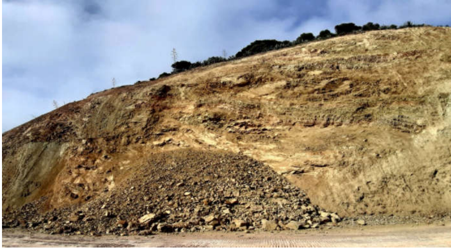
Figure 2.17 : Glissement de débris et Chutes de bloc (schistes d'argile)
