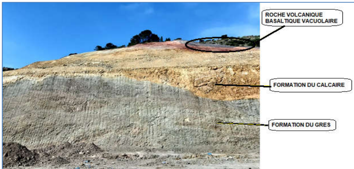
Figure 2.5 :Formation géologique de section PK0+180-PK0+330 (S2)
