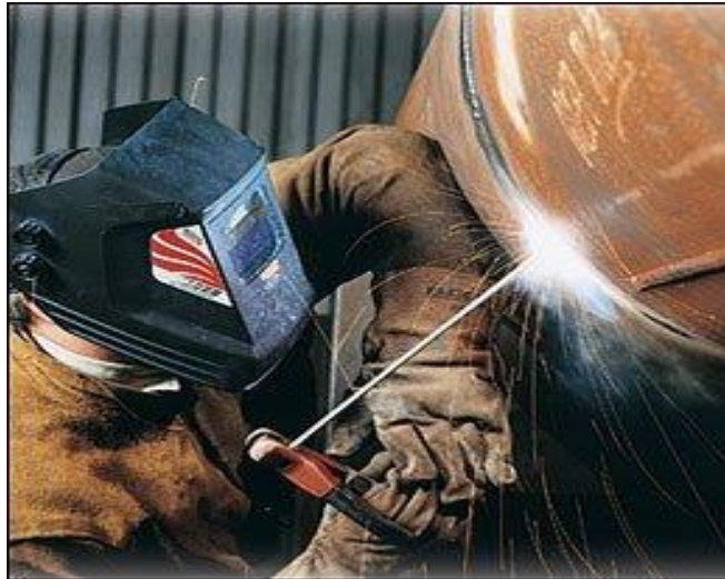
Figure 7: Soudure à l'arc électrode
