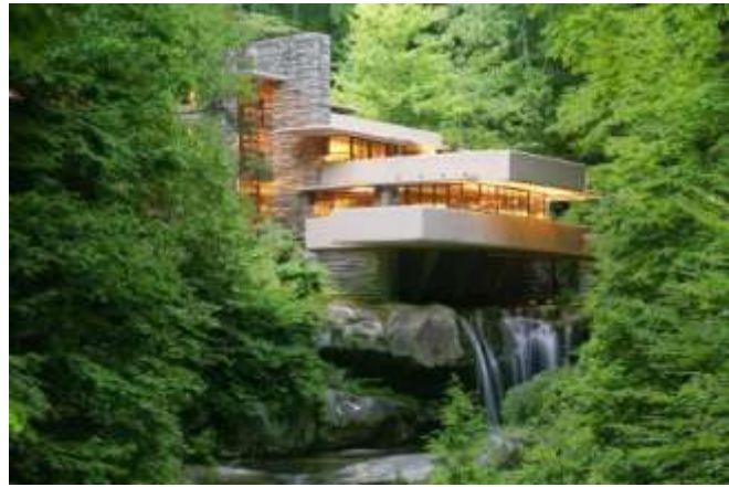
Figure 08 : la maison de la cascade (source google image)
