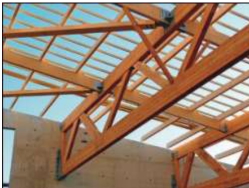
Figure 109 : des poutres en lamellé collé
