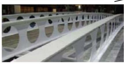
poutre alvéolaire fabriqué a partir des profilés en IPE( augmentation de l'inertie accompagnée d'une diminution de l'épaisseur de l'âme
