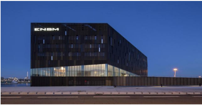
Figure 81: la façade nord de l'école
