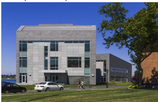
Figure 61: la façade est du centre
