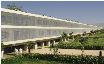
Figure 46: la façade sud de l'hébergement
