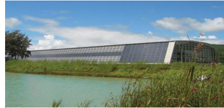
Figure 30: la façade sud des ateliers
