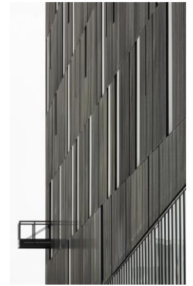
Figure 83: traitement de la façade
