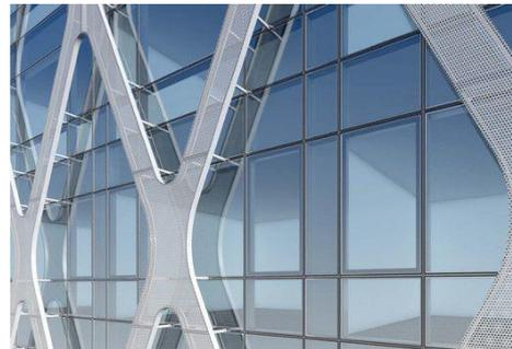
Figure 157: Fixation des éléments décoratifs de la façade
