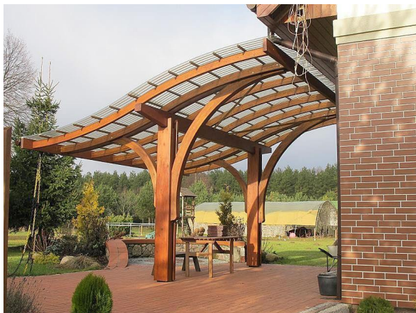
Figure 74 : poteaux en bois lamellé collé
