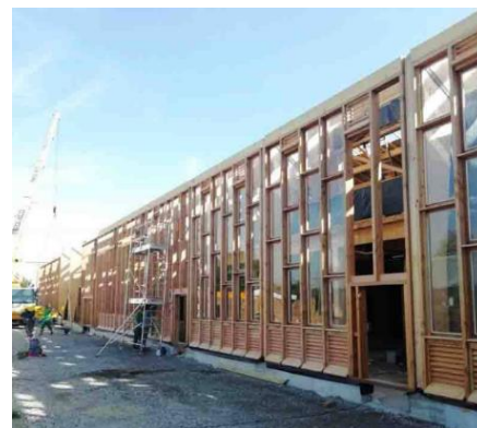
Figure 119 : les façades vitrées
