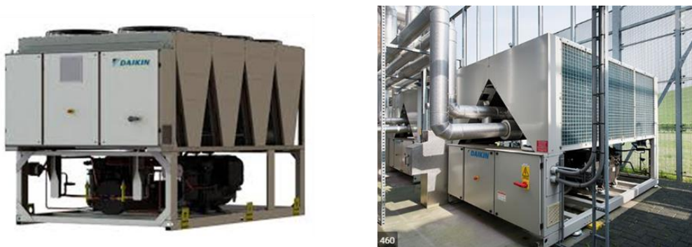
Figure 85: Centrale de climatisation à eau glacée
