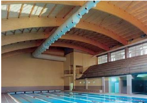
Figure 72: toiture en bois lamellé collé
