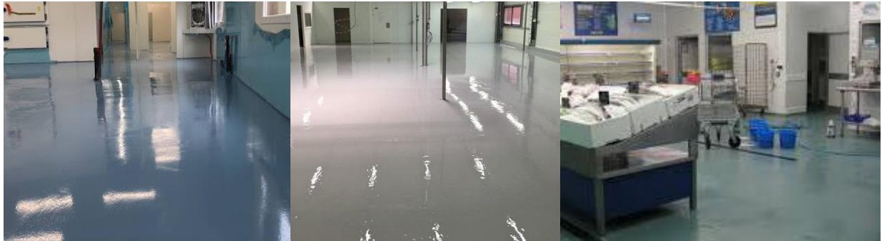
Figure 83 : Revêtement de sol en mortier de Résine
