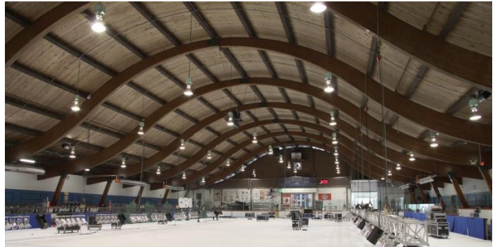
Figure 73 : Toiture en bois lamellé collé -L'aréna Eric-Sharp-
