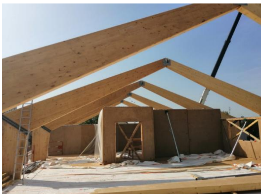
Figure 120 : la charpente en bois
