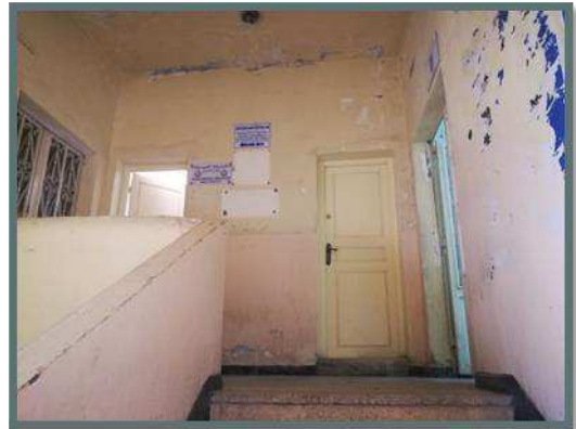
Figure 15 prise de vue a l'intérieur du bloc 1 (annexe APC) ; source: l'auteur
