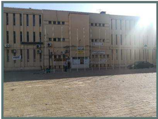
Figure 15 prise de vue de l'extérieur du bloc 1 (annexe APC); source: l'auteur
