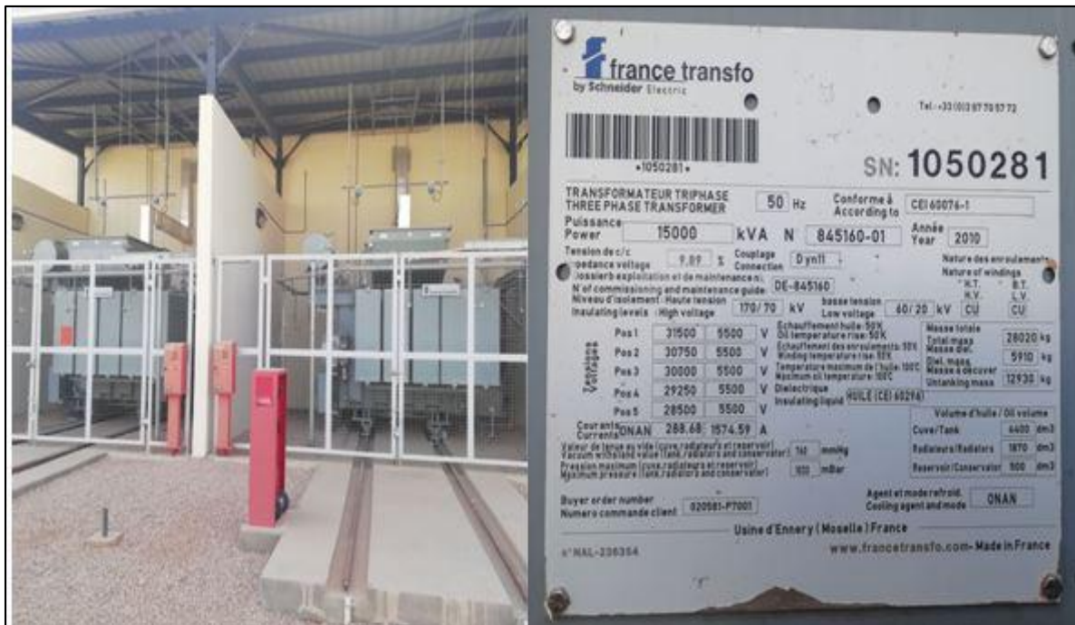
Fig. IV.10 : Schéma des deux transformateurs de puissance de 15 MVA avec leur plaque signalétique.
