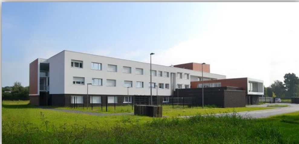
Figure 62: Façade sud d'ehpad
