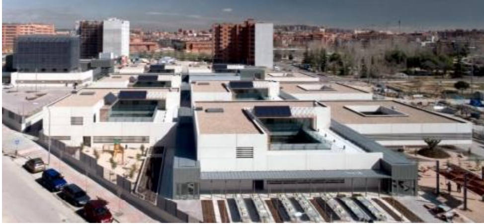
Figure 37: vue sur l'exterieure du centre d'alzheimer Reina Sofia
