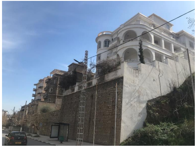
Figure 101: Facades sur le boulevard l'ALN
