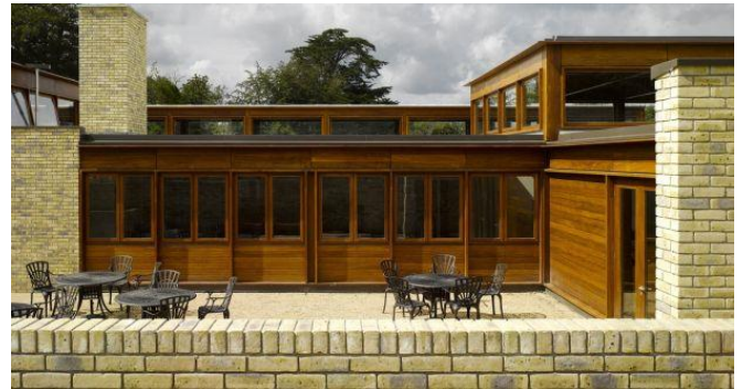
Figure 24: vue sur la terrasse
