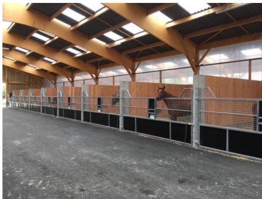
Photo 57. Exemple de construction de box pour chevaux. (Source : Page Facebook : 720 • ICON Architecture)
