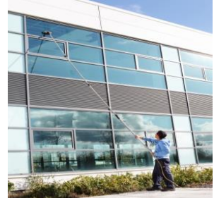
Photo 69. Le nettoyage de mur rideau.
