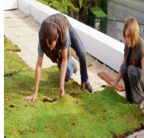
Photo 68. L'entretien d'un toit végétalisé.
