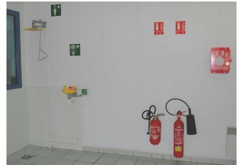
Photo 37. Moyens de sécurité (à maintenir dégagés et à vérifier périodiquement), avec leur pictogramme. (Source : https://fr.wikipedia.org )
