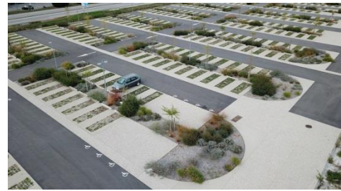
Photo 63. Parking végétalisé. (Source : http://www.sols.fr )
