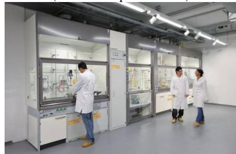
Photo 40. Sorbonne de laboratoire. (Source : https://rvs-ltd.ru/laboratornaya-mebel.html )
