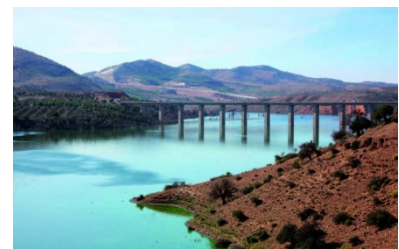
Photo 27. Barrage de Hammam Boughrara
