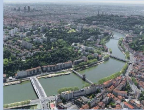
Les berges des Rhône
