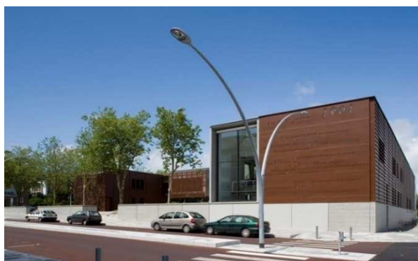
Figure 65 : soubassement en béton gris matricé source : ibid.
