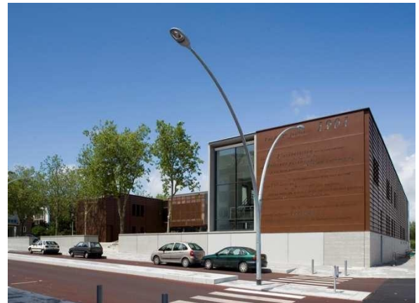
Figure 61 : vue sur la maison d'association Saint-Nazaire source : caue-observatoire.fr/ouvrage/maison-des-associations
