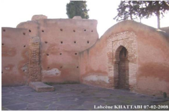
Figure 28 : ksar sultan après sa restauration source : Mr.khettabi lahcen
