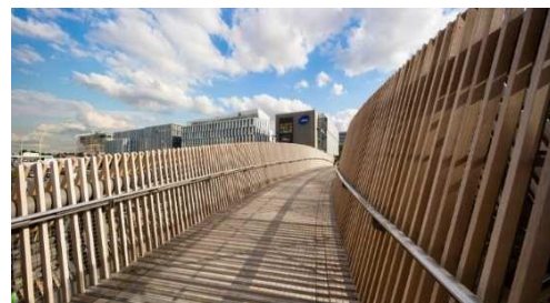
Figure 141 : vue sur le bardage en bois, source : http://fr.wikipedia.org/wiki/Passerelle Claude-Bernard
