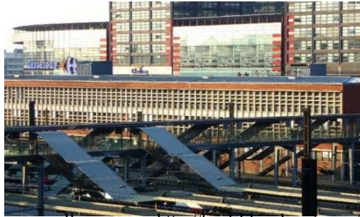
Figure 139 : vue sur la passerelle, source : http://beal-blancaert.com/projets/014-sncf_passerelle/
