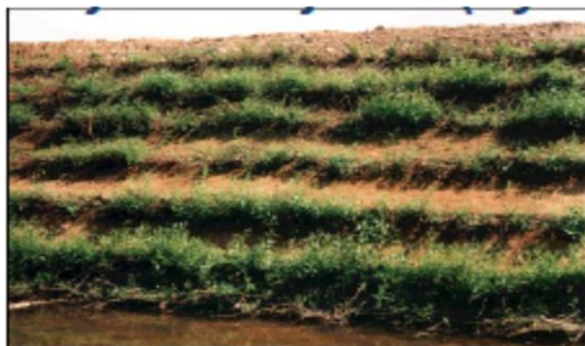
Figure 170 : protection des berges par génie végétal, source https://www.google.com/search?q=protection+
