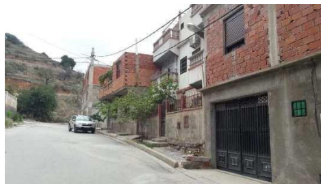
Figure 87 : vue sur les maisons existantes source : auteur
