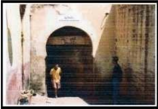
Figure 23: Bâb el madina avant sa restauration en 1995
