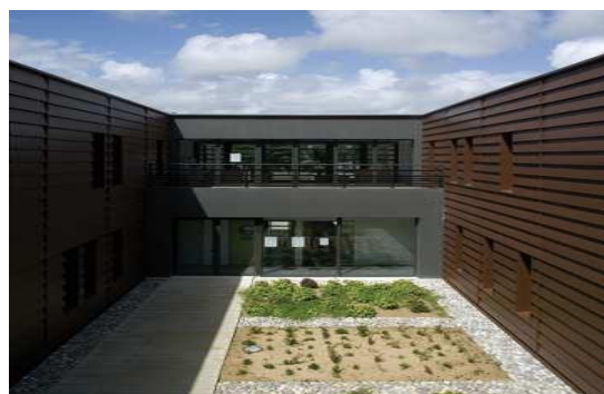
Figure 64 : vue sur le patio, source : ibid
