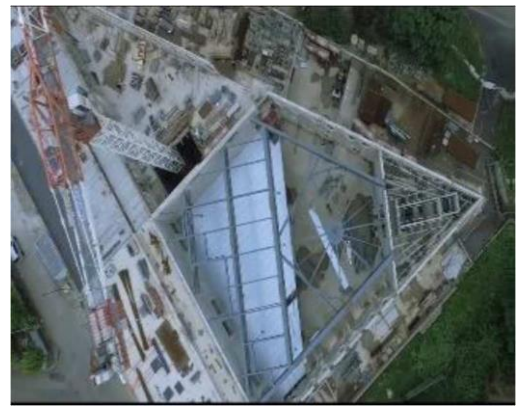
Figure 49 : technique de construction du centre, source : ibid
