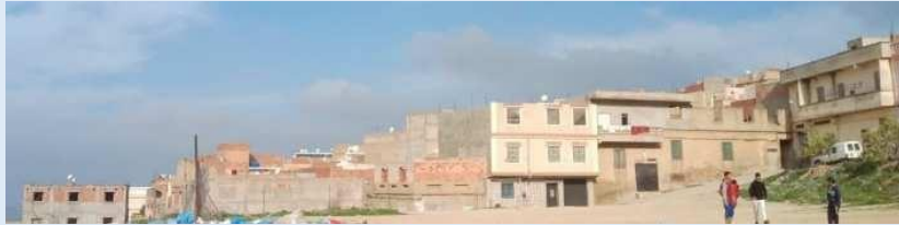
Figure 74 : vue nord vers les maisons existante dans la médina source : auteur
