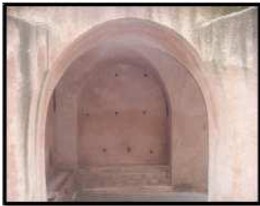
Figure 25 : porte casbah après sa restauration 2011
