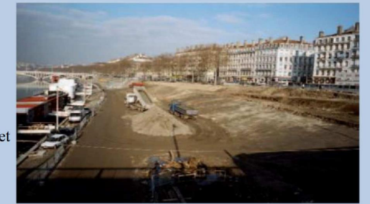
Travaux d'aménagement du Rhône Source : blogs.grandlyon.com
