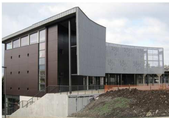
Figure 55 : vue sur la façade principale source : archiliste.fr/atelier-architecture-urbanisme
