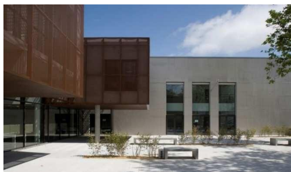
Figure 66 : panneaux en aciers et aluminium recouverts les boîtes en béton source : ibid.
