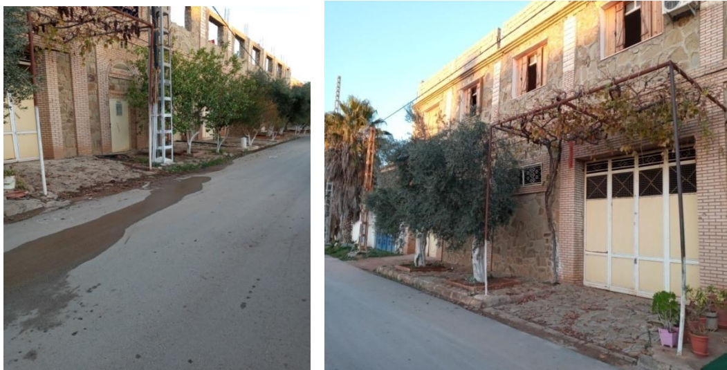
Figure II.4 : Vue de façade de la Maison
