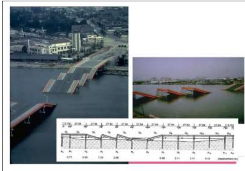
Figure 1.2: Rupture du pont de Showa, à Niigata au Japon
