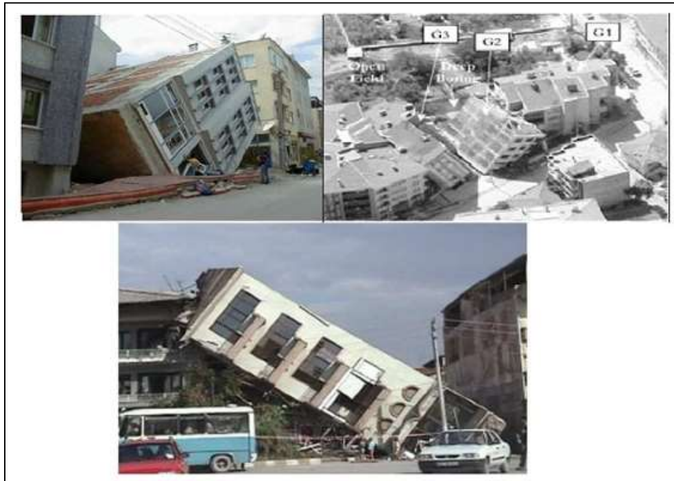
Figure 1.4: Bâtiments renversés (Séisme de Cocaeli, Adpazari, 1999)
