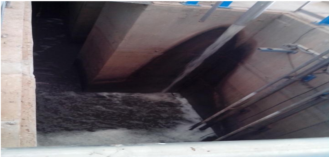
Figure II.8. Piège à sable (Terga)
