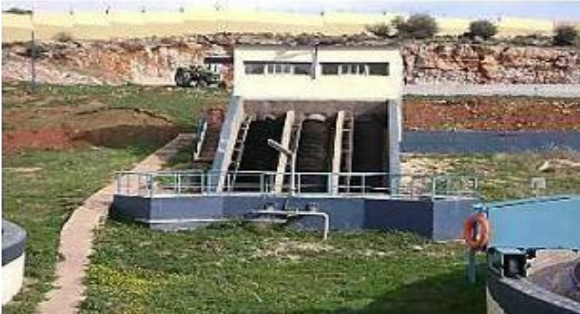
Figure II.27. Vis relevage des boues (Ain El Houtz)
