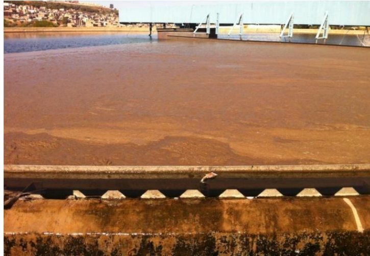
Figure IV.1 : la remonte des boues (21/12/2015)
