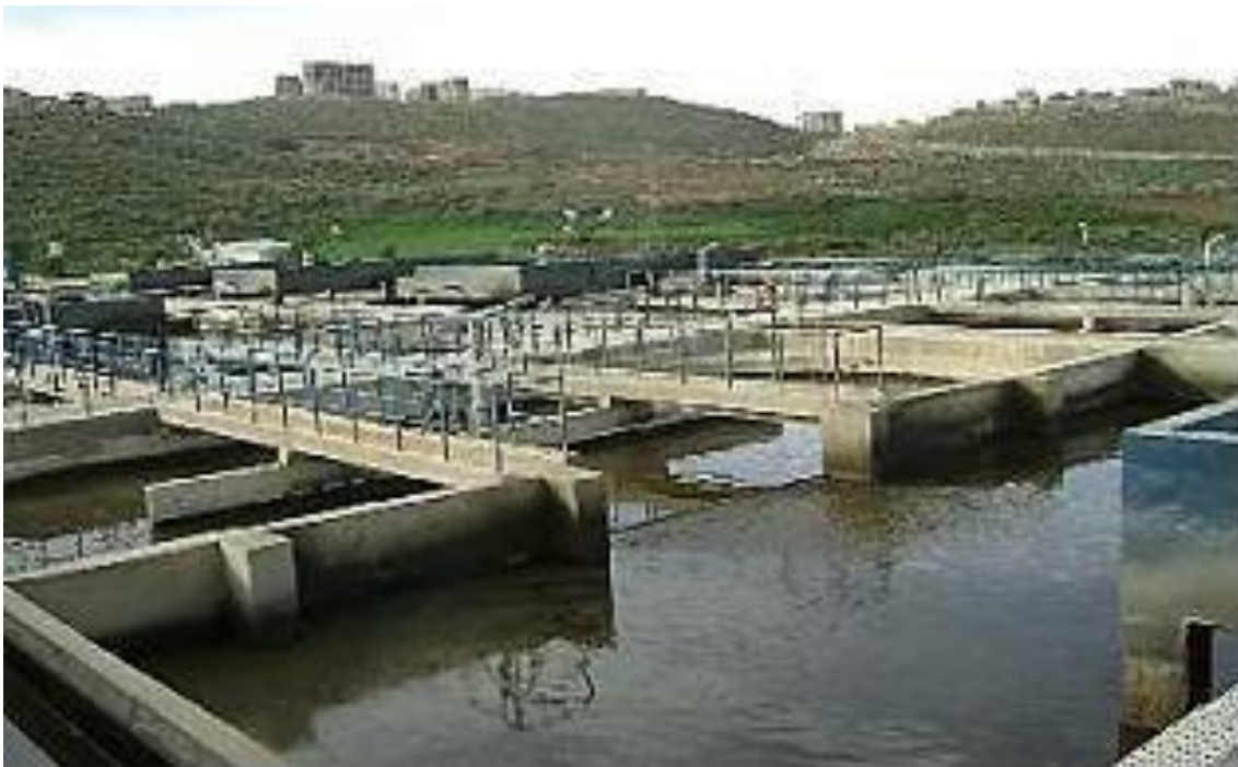
Figure II.24. Bassins d'aérations (Ain El Houtz)
