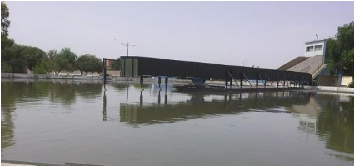
Figure II.37. Décanteurs secondaires (Ain Bouchakif)
