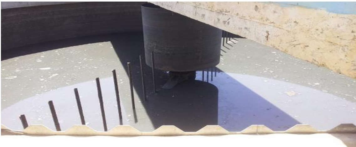
Figure II.39. Épaississeur de boue (Ain Bouchakif)
