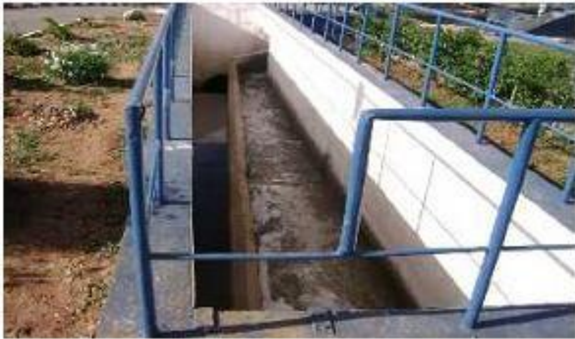
Figure II.20. Déversoir d'orage (Ain El Houtz)
