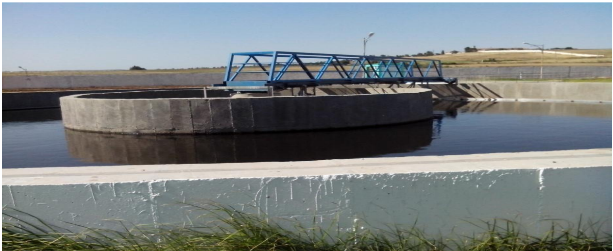
Clarifloculateur (Terga) .Figure II.15
