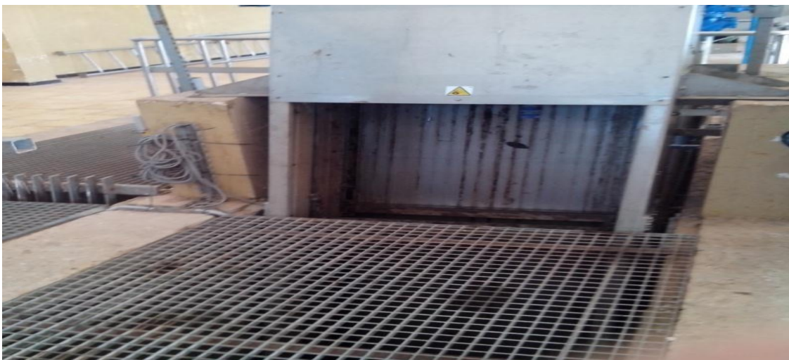
Figure II.7. Grille mécanisée grossière (Terga)
