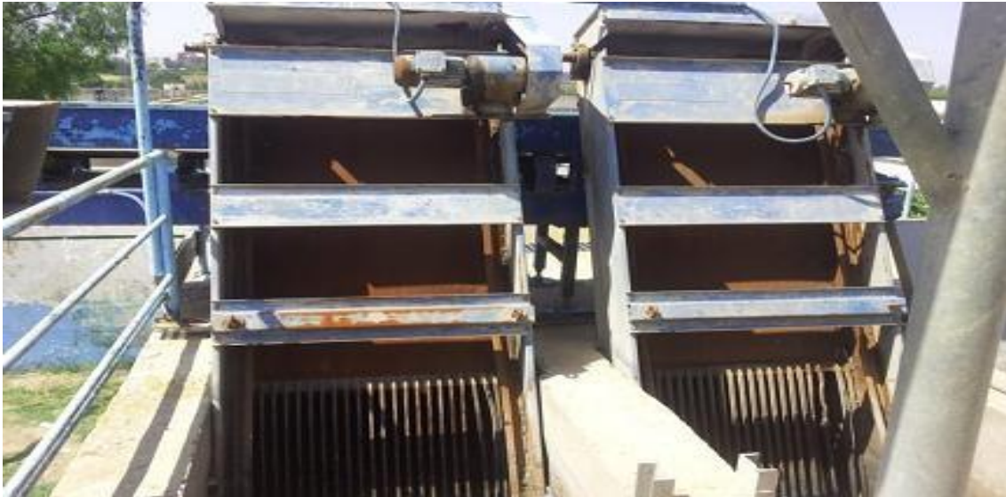
Figure II.33. Grilles mécaniques (Ain Bouchakif)
