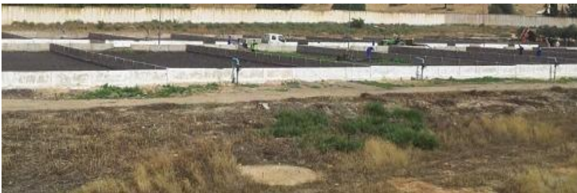
Figure II.40. Lits de séchages (Ain Bouchakif)
