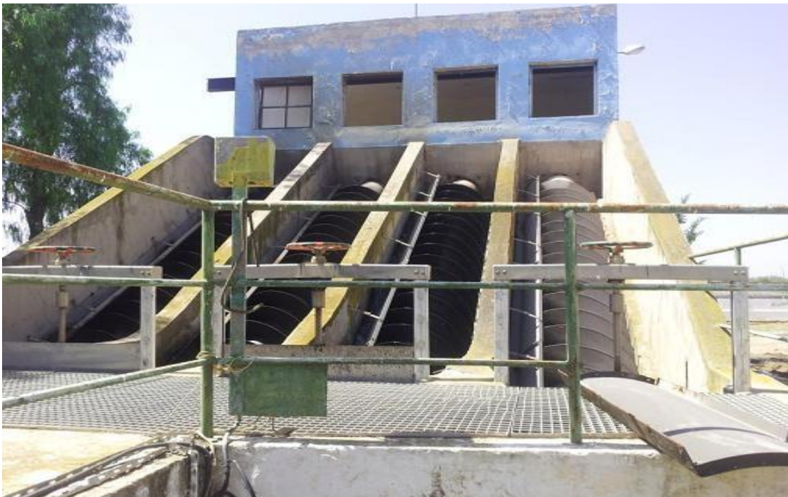
Figure II.32. Bâtiment de relevage (Ain Bouchakif)
