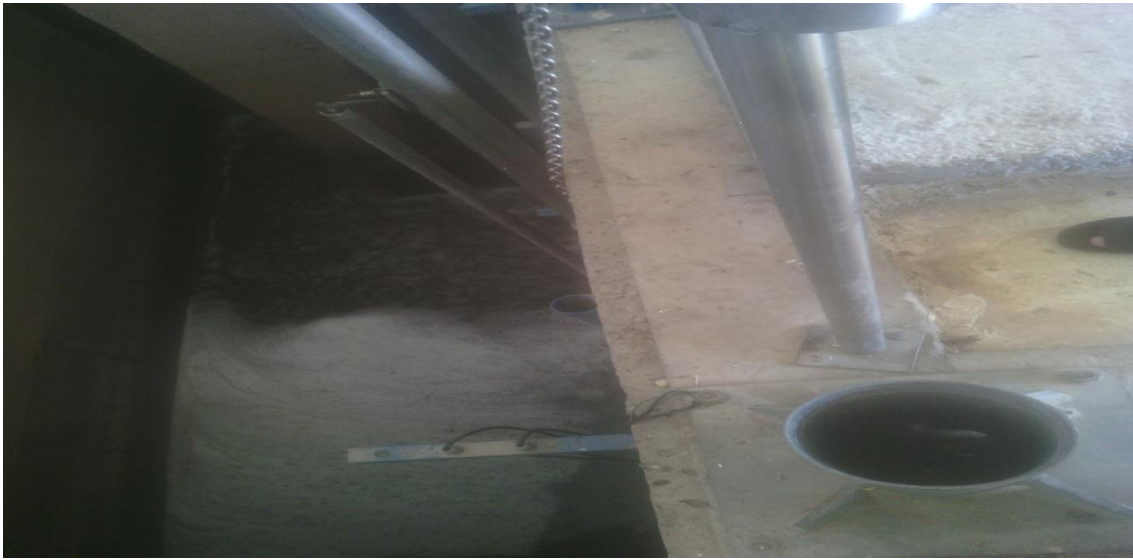
Figure II.5. Déversoir d'orage (Terga)
