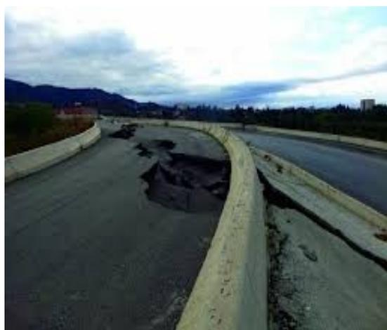
Figure I-5 : Dégradation de chaussée [f-5]
