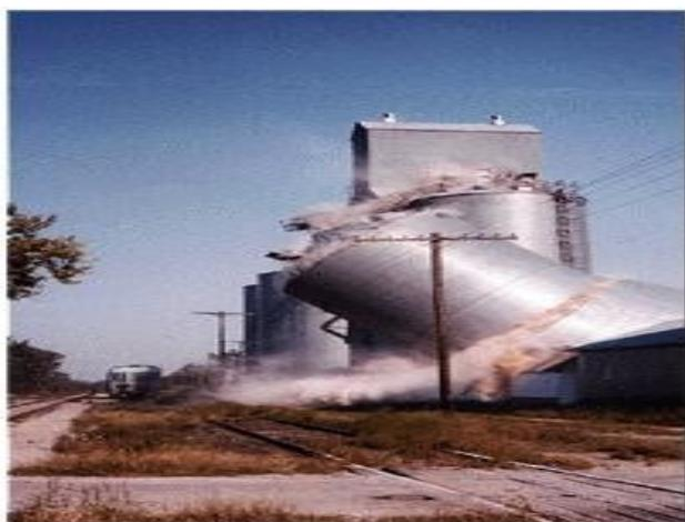
Figure I-4 : Effondrement d'un silo [f-4]
