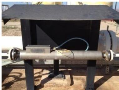
**Fig. 2. 7** Densimètre Electronique
