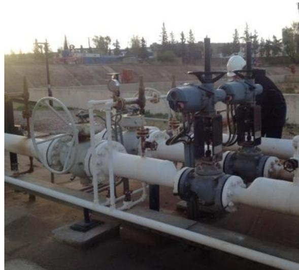
Fig. 2. 9 Prise en ligne d'échantillon du mélange (Interface)
