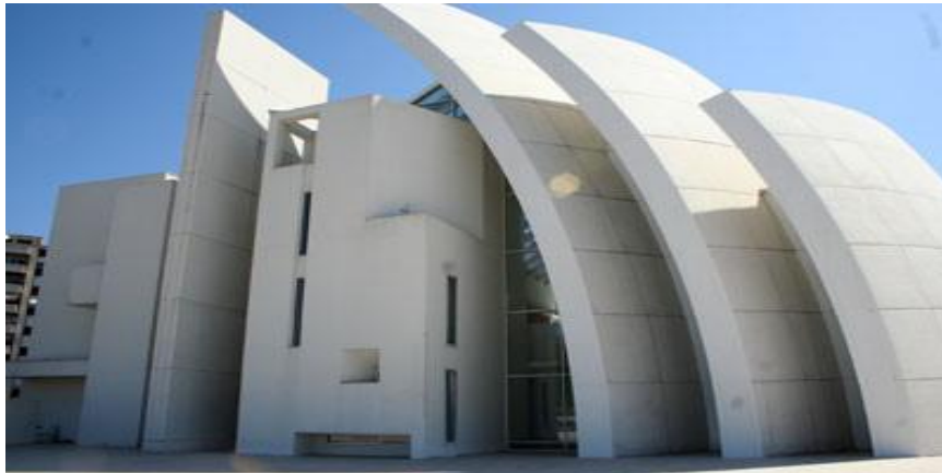
Figure 1.13 : église du Jubilé à Rome, contenant du TiO 2 nanométrique dans son ciment [46].
