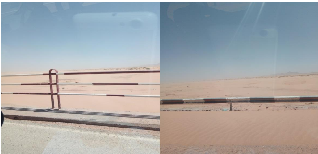
Fig. 13. La situation actuellement du Barrage ensablé à 100% ( Hadidi, 2018)
