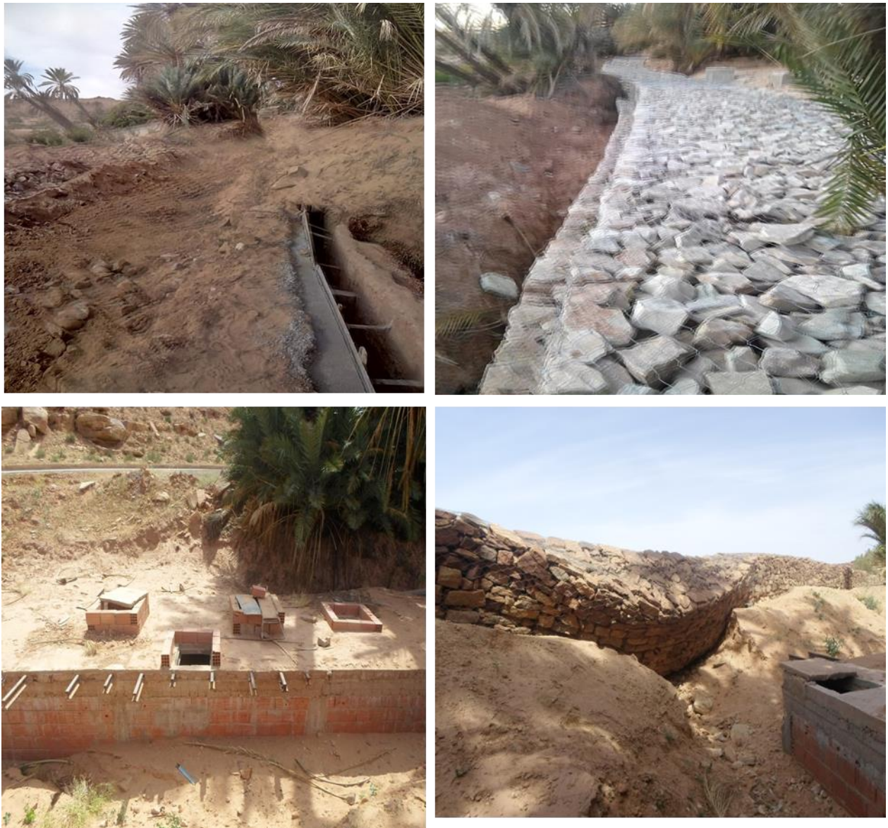
Fig. 19. Les travaux et l'entretien de la foggara (Hadidi ,2018)
