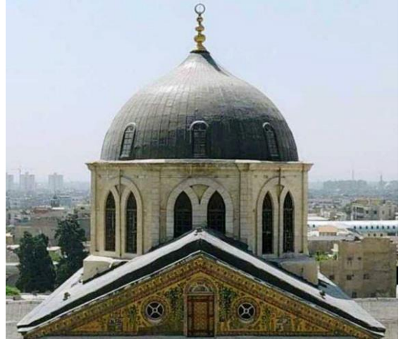
صورة 21: صورة توضح قبة النسر بالمسجد الأموي بدمشق، وهي قبة مستديرة، مغطاة بالرصاص.
