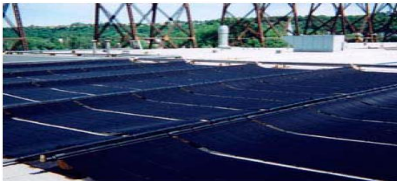
Figure 1.6 : Capteur plan non vitré [23]
