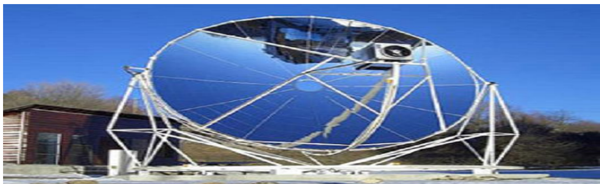
Figure 1.9 : Concentrateur parabolique [25]
