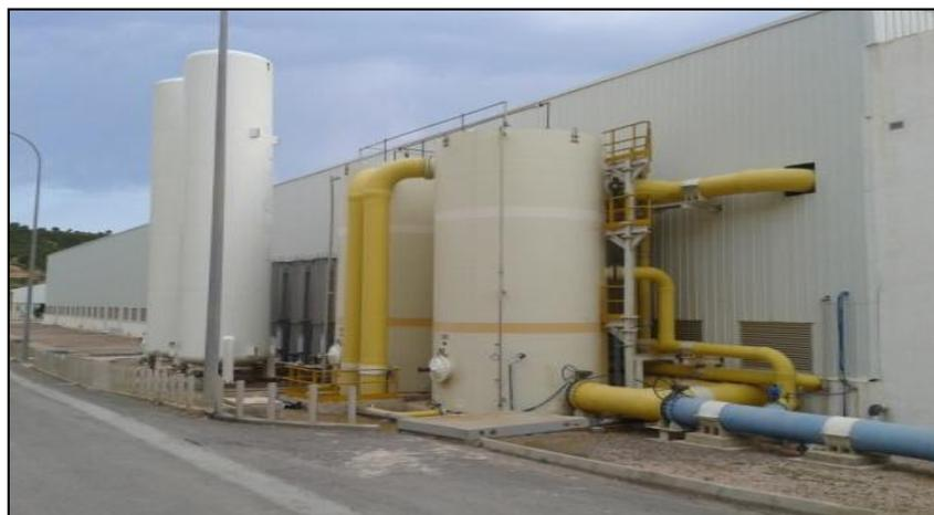
Figure 2-20 : Réservoir de  $CO_2$
