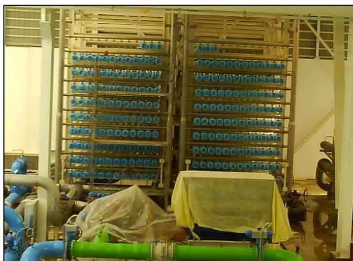
**Figure 2-13 : Châssis à membrane**
