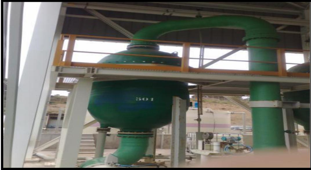
**Figure III.12 :** Filtres à cartouches (microfiltration) au niveau de la station (Station de Dessalement- Honaine) [10].
