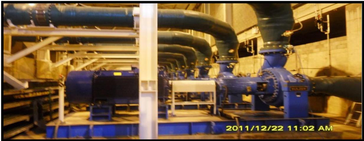
**Figure III.7 :** Le bloc des pompes de captation au niveau de la station de Honaine[10].
