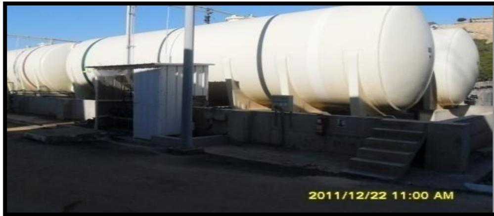
Figure III.9 : Citerne de stockage de chlorure ferrique [10].
