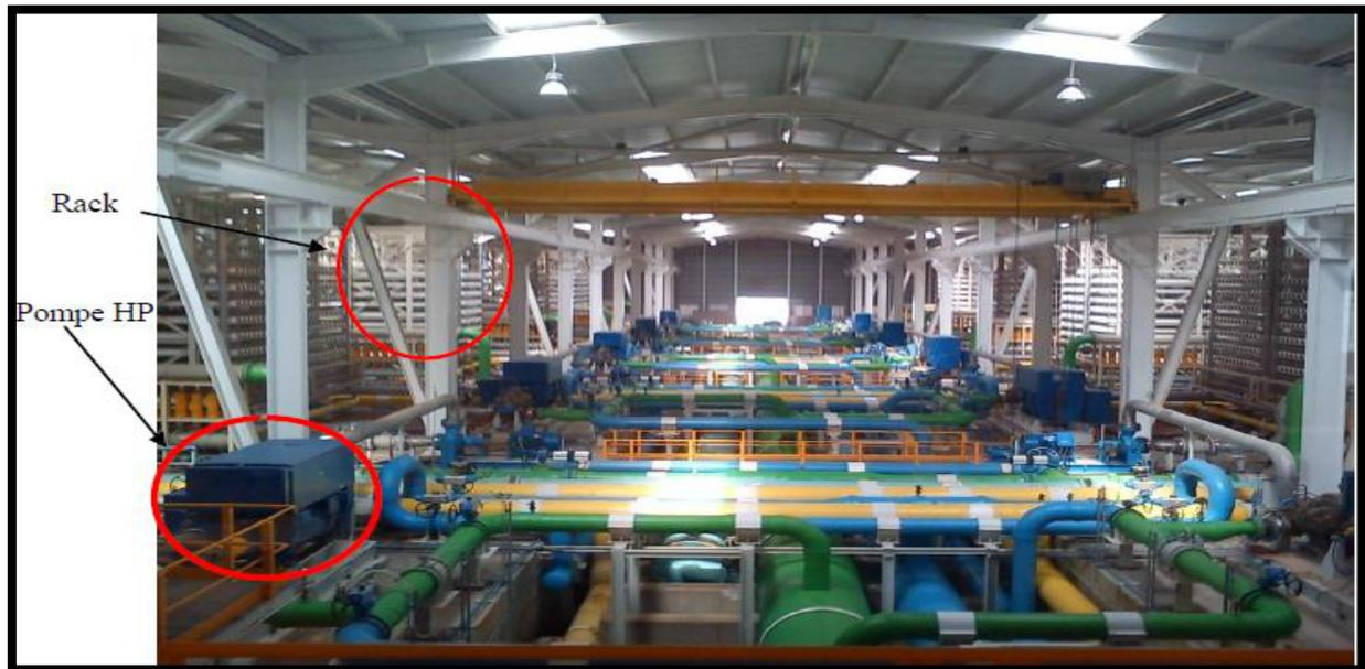
**Figure III.13 :** Bloc d'osmose inverse (Station de Dessalement- Honaïne)[10].
