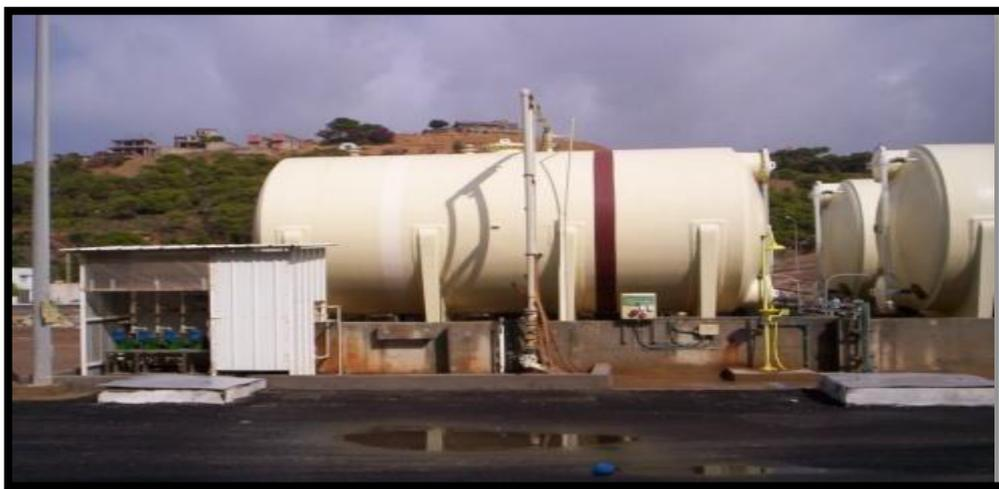
**Figure III.8 :** Citerne de stockage d'hypochlorite de Sodium[10].
