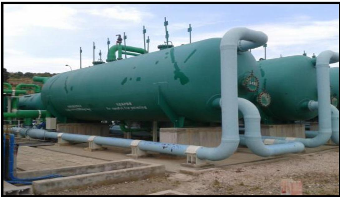
**Figure III.11 :** Filtres à sables et anthracite (Station de Dessalement-Honaïne) [8].
