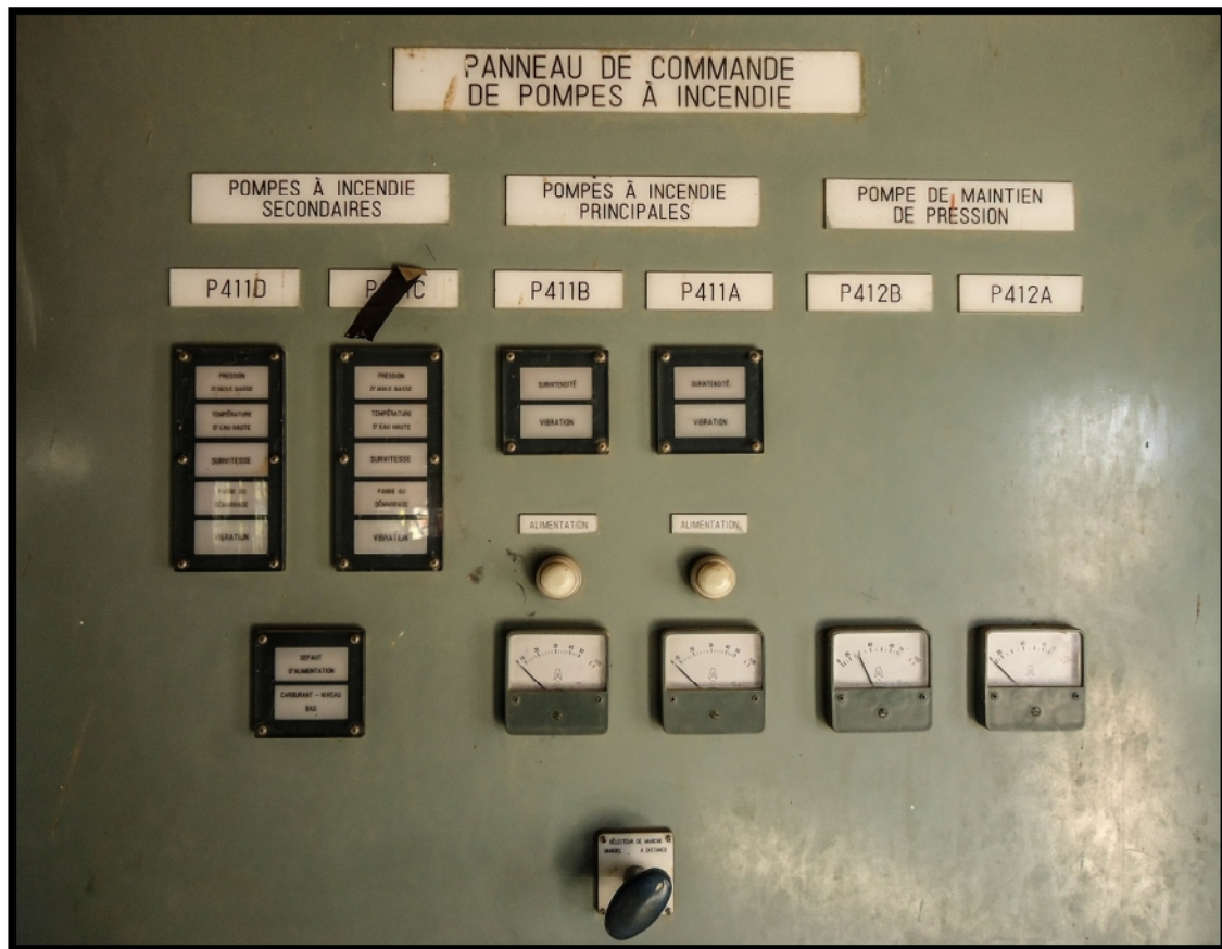
Figure IV.4: L'opérateur du poste incendie
