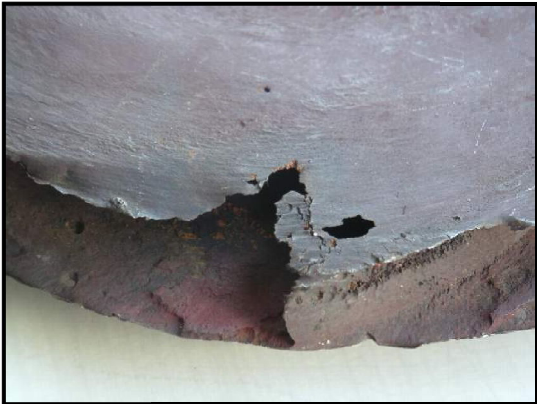
Figure III.4: Usure par cavitation d'un impulseur de pompe centrifuge
