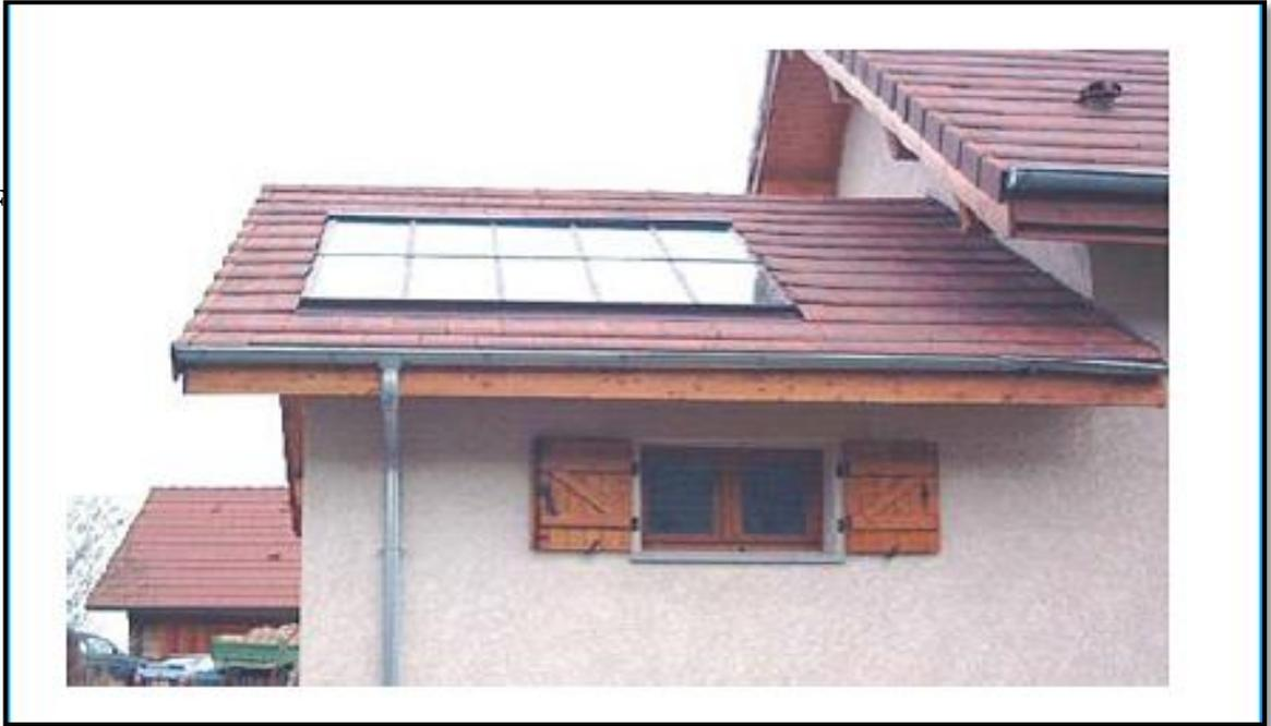
**Figure II- 15 : Photo représentant un Chauffage d’habitat par un capteur plan à air**
