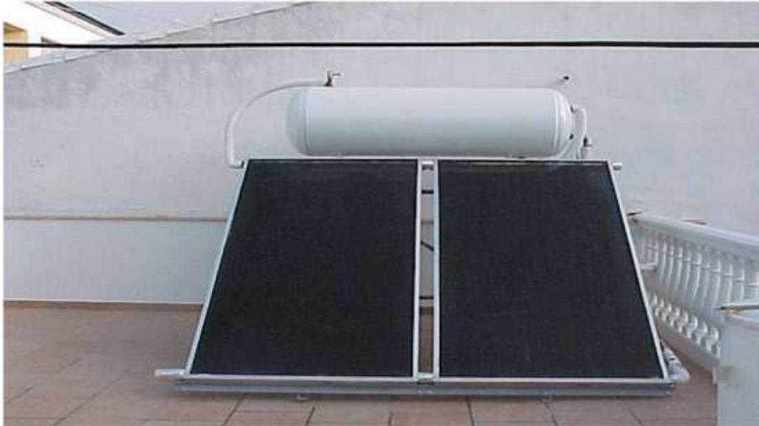
*Figure III. 4 Capteur solaire plan à eau*
