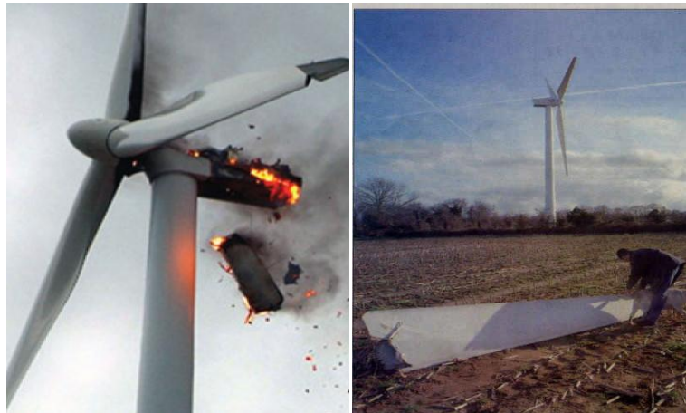
Figure 2.18. Incendie d'une éolienne à cause de la foudre à gauche, Pale brisée par la tempête à droite [36].
