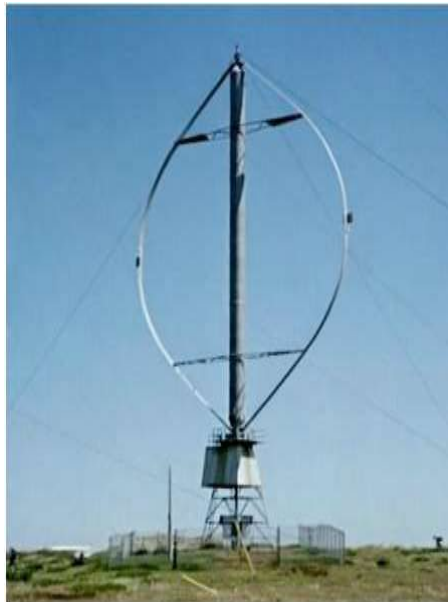
Figure 1.3. Éolienne de Darrieus [3].
