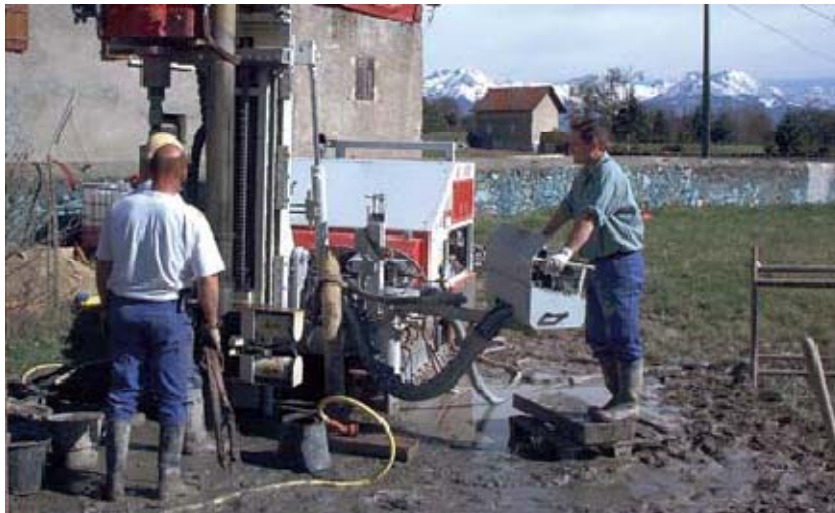
Figure 1 : Réalisation d'un forage avant la pose d'un échangeur. [8]
