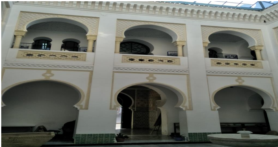
الصورة رقم(20): توضح كثرة النوافذ والأبواب في البناية
