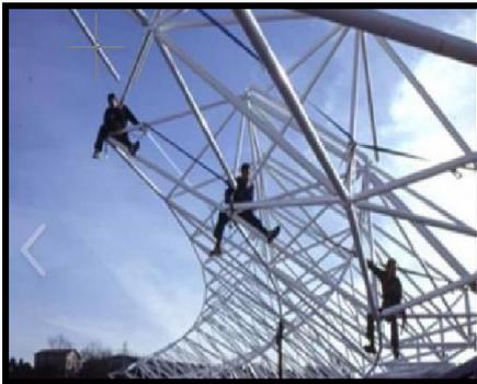
**Figure 106** : les barres sous forme des arcs tubulaires
