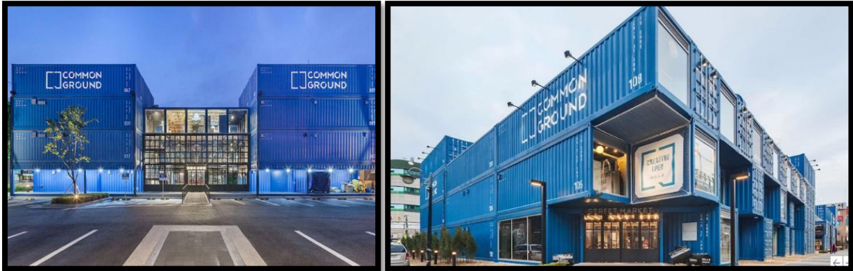
Figure 25 : centre commercial en containers de Corée
