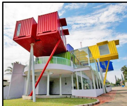
Figure 19: surélévation en conteneur
