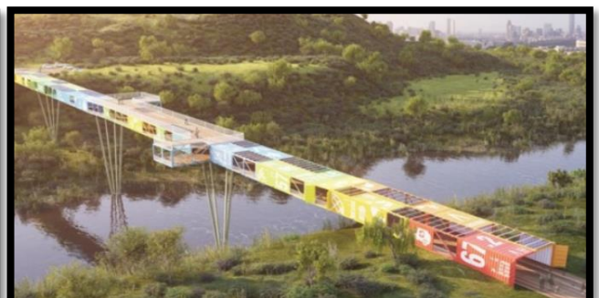
Figure 24 : Pont en Conteneurs à Tel Aviv
